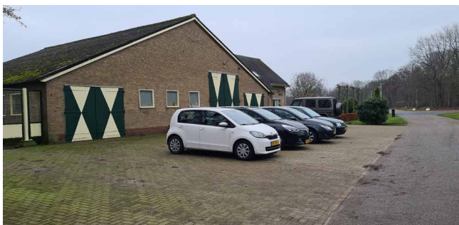
Figuur 11: De te slopen boerderij aan de IJper 5.1.2e
