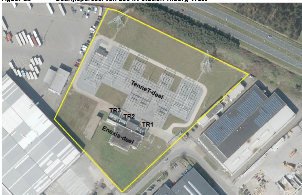
Figuur 1b Bedrijfsperceel van 150 kV station Tilburg-West
