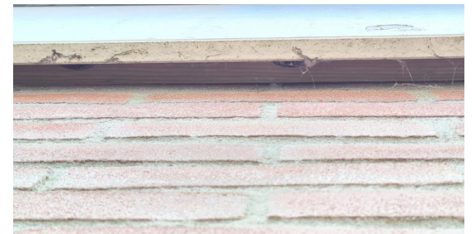
Figuur 9: Detail foto van dakrand te slopen garage
