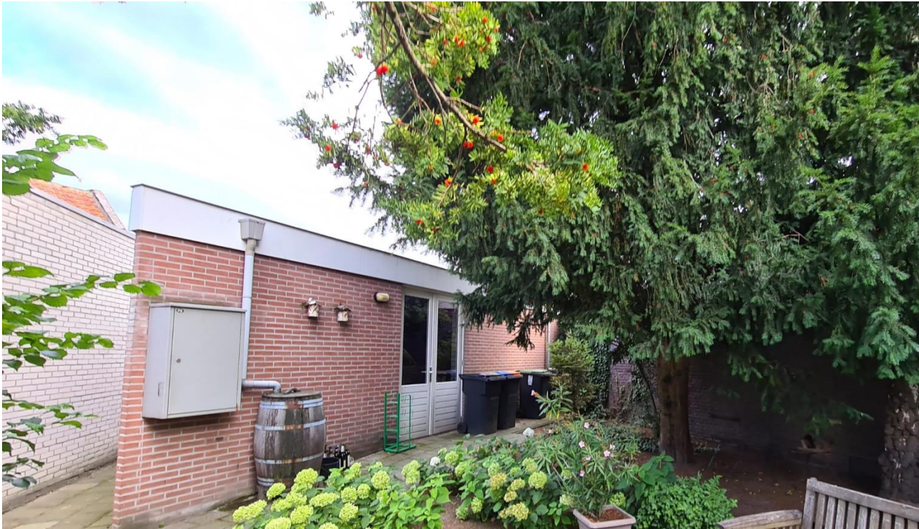
Figuur 4: Te slopen garage aan noordkant perceel
