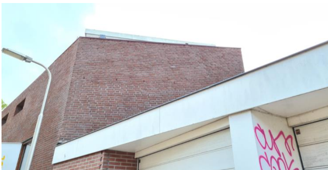
Figuur 7: Te slopen garage en aangrenzend gebouw
