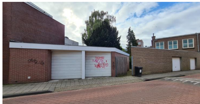
Figuur 8: Te slopen garage gezien vanaf Diepenstraat
