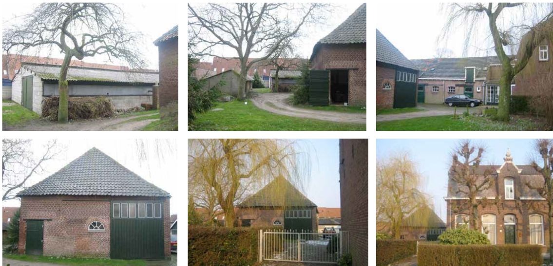
De bebouwing op het terrein in betere tijden (bron: MAG Architecten, Wieggers Architect)
