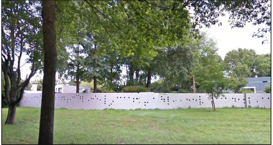
Figuur 4.2 Bestaande afscherming tussen Baroniebaan en nieuwe woning
