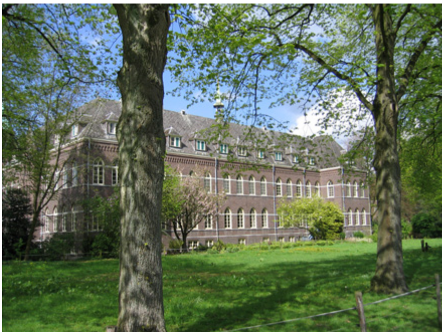
hoofdgebouw Adbij (zuidwestzijde)
