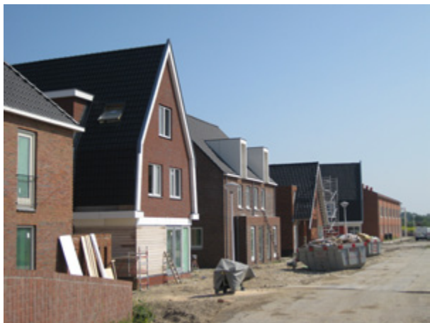
baksteen voert de boventoon
