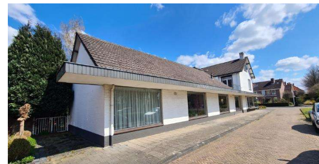
Figuur 5: Te slopen pand gezien vanaf Raadhuisstraat
