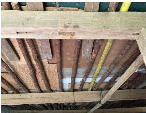
Deze trekbal heeft nog de pengaten van zijn functie als standvink. De stijl is later meer naar het midden verplaatst.
