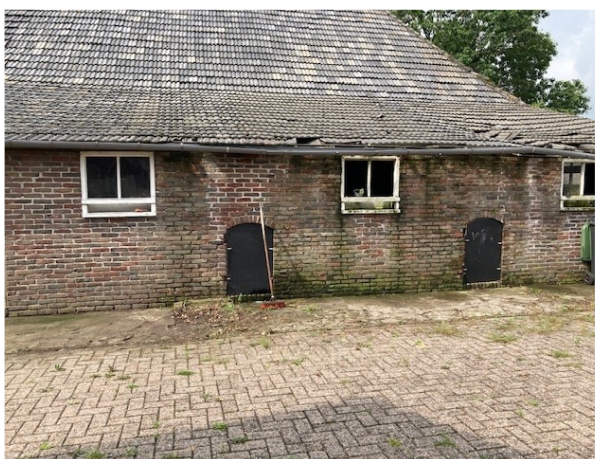
Oostgevel met varkensdeurtjes en stalramen
