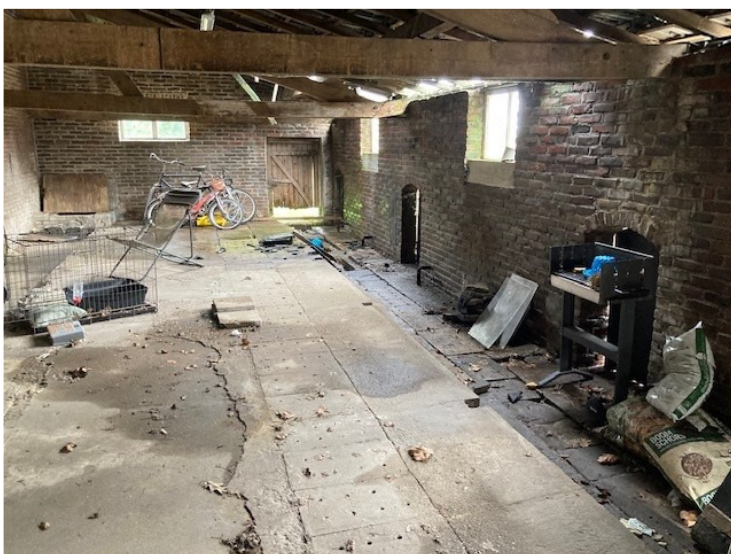
Interieur van de varkensstal met de gesloopte varkenshokken..
