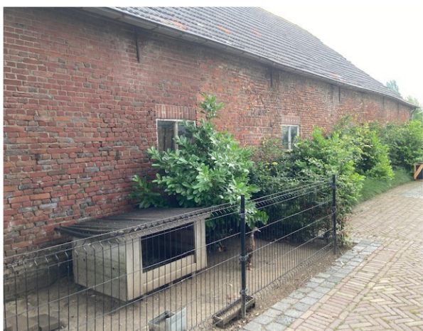
Westgevel met diverse oude geveldelen
