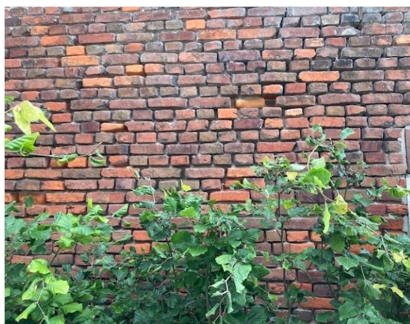
Oud muurwerk in kruis- en wildverband in westgevel
