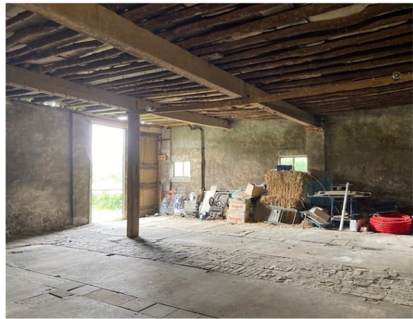
Interieur gezien naar hoek westgevel en zuidgevel. Ook hier heeft de trekbal een stijl.
