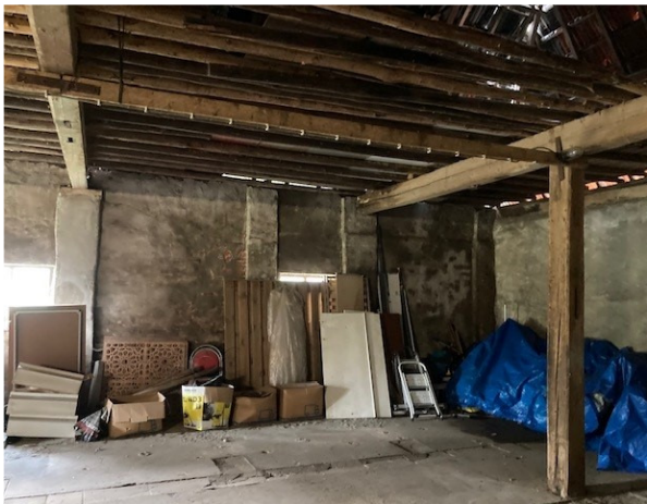
Interieur gezien naar de hoek westgevel en noordgevel. De trekbal rechts heeft een stijl. Tussen de twee penanten in het midden van de foto bevond zich oorspronkelijk een loopdeur.
