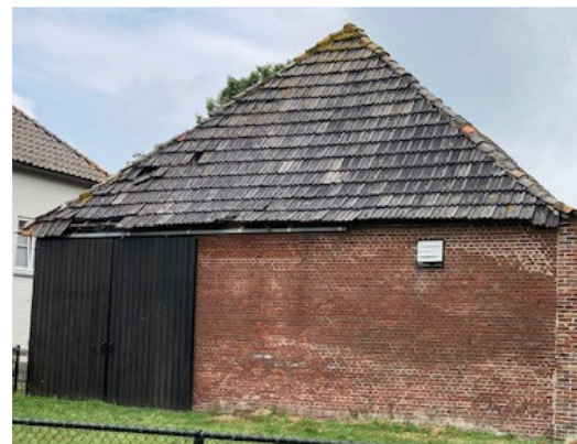
Vlaamse schuur met dragende stenen wanden.
