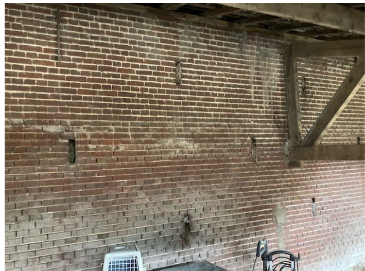
Oostgevel van de schuur is thans de tussengevel met de aangebouwde varkensstal. De gevel heeft verfijnd voegwerk. Er zijn in de gevel geen sporen van dichtgezette halve maantjes.
