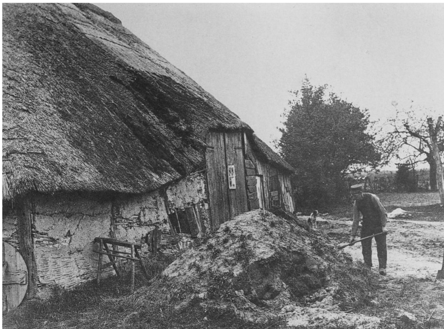
Dwarsdeelschuur uit de omgeving van Tilburg. De schuur heeft nog haar archaïsche vorm. Het dak welft bij de deeldeuren op. De schuur heeft een gebint en wanden van vitselstek.
