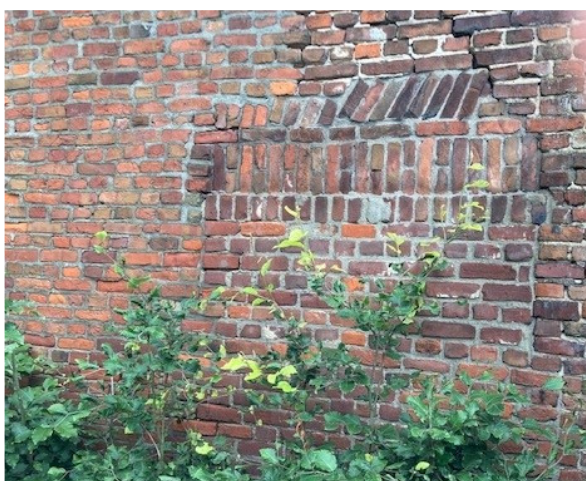
Bouwsporen in westgevel van o.a. dichtgezette loopdeur. Het restant van de stroomlaag wijst er op dat de gevel oorspronkelijk lager zal zijn geweest.
