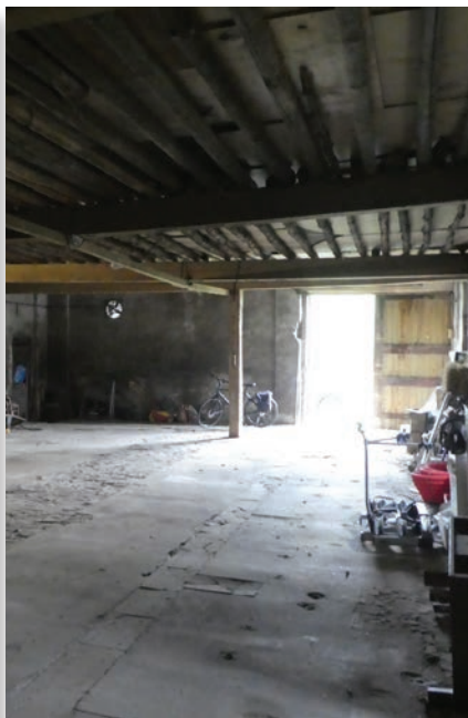
Binnenruimte met ontbrekende standvinken.
