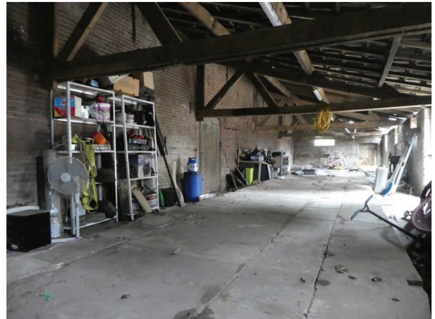
De dakconstructie van de aanbouw uit 1963 mits gehandhaafd behandelen als de dakconstructie uit 1914-1915.
