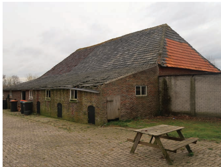
De dakbedekking van het westelijke dakschild bestaat aan de veldzijde uit overwegend rood-gebakken muldenpannen.
