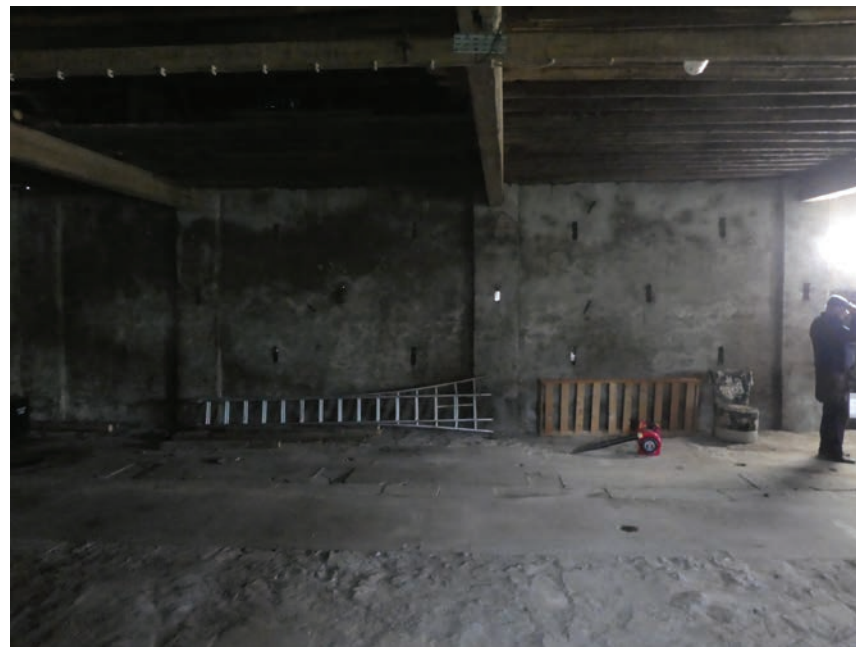
Zuidzijde van scheidsmuur waarin patroon van luchtopeningen goed te zien is.
