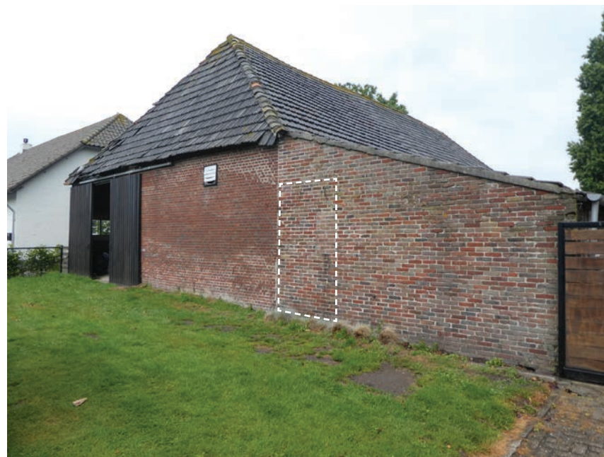
Overzicht van oostgevel, rechts de nieuwere muren uit 1963. Het geveldeel binnen stippellijn wordt in de plannen mogelijk verwijderd voor een deuropening.
