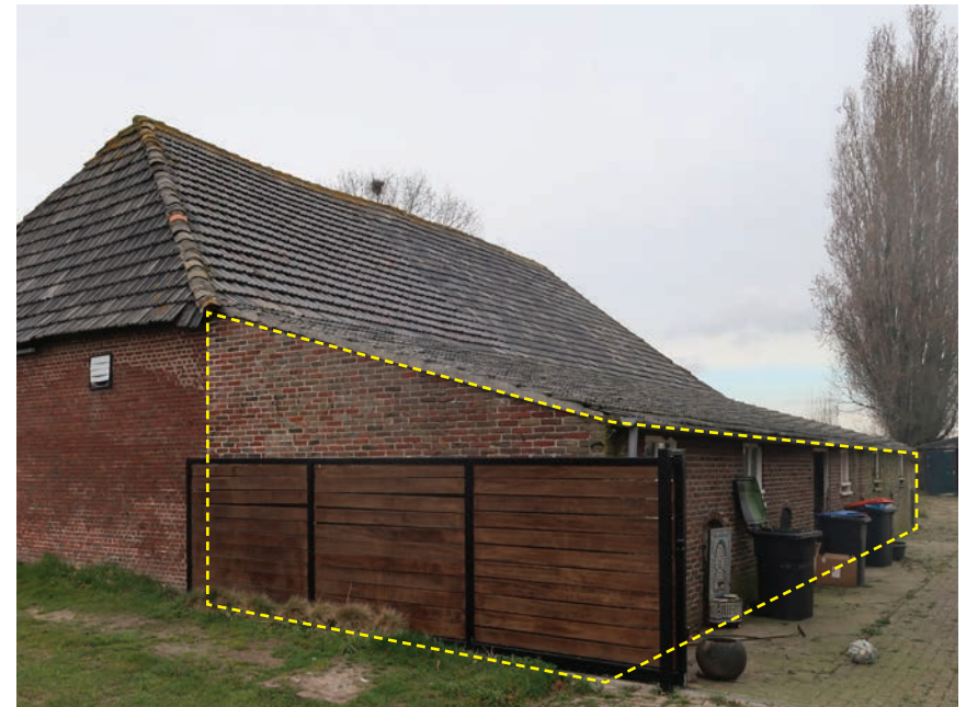
De gevelopeningen van de te handhaven muurdelen van uitbreiding uit 1963 kunnen worden dichtgemetseld. Het roze gekleurde geveldeel wordt in de plannen mogelijk verwijderd.
