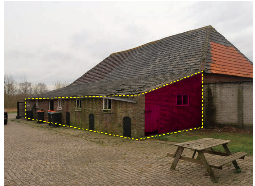
De gevelopeningen van de te handhaven muurdelen van uitbreiding uit 1963 kunnen worden dichtgemetseld. Het roze gekleurde geveldeel wordt in de plannen mogelijk verwijderd.
