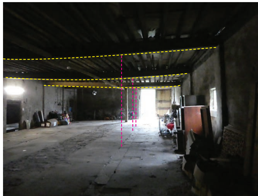
Doorbuigende moer- of gebintbalen. In roze de positie van de oorspronkelijke standvinken of gebintstijlen
