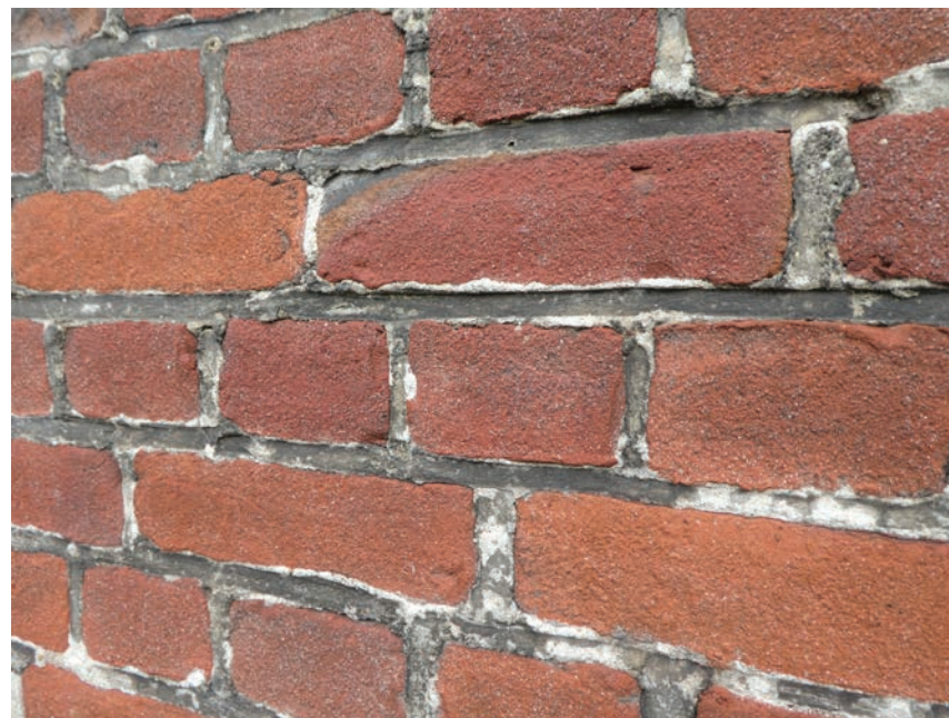
Detail van hervoegd metselwerk van oostgevel.
