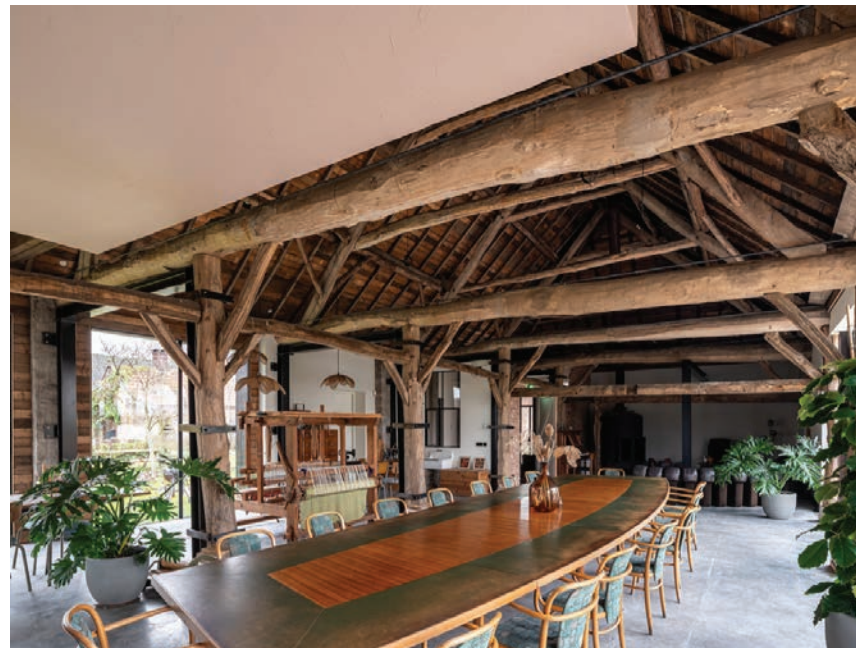
Referentie van compleet houtskelet van een zij-longsdeelschuur met standvinkconstructie en afgeschoorde koppelbalken.
