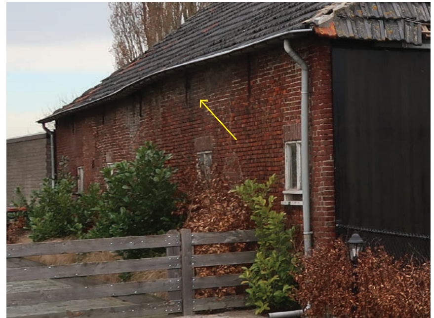
Overzicht van zuidgevel met bolling.
