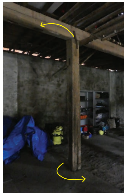
Gedraaide standvink met verwijzingspijl naar oorspronkelijke positie.
