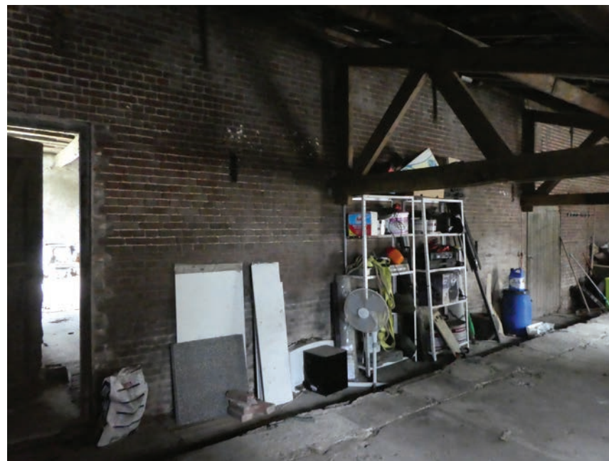
Noordzijde van scheidsmuur met oorspronkelijke voegafwerking en toegevoegde spanten.
