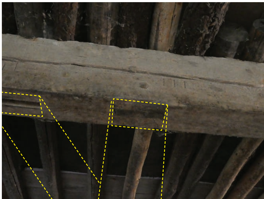
Deels gevulde pengaten die duiden op de oude plaatsen van de stijlen en korbelen van de oude constructie. Hier telmerk III.
