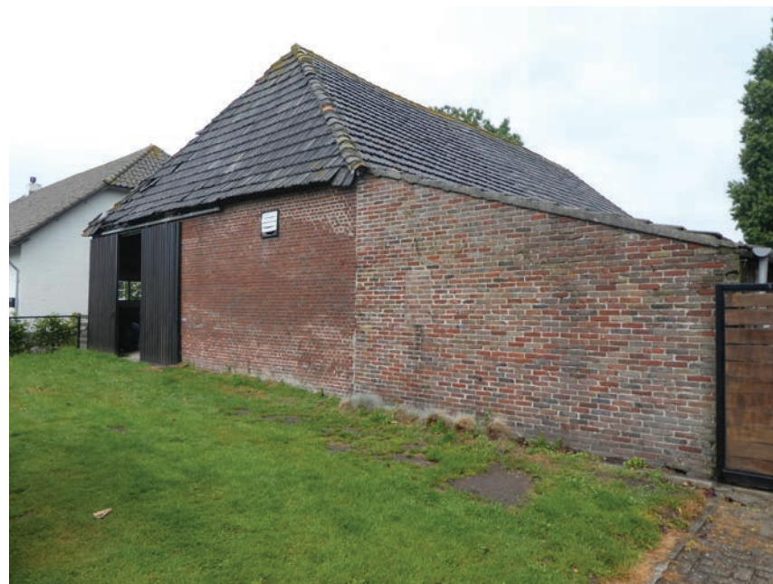
De dakbedekking van de schuur bestaat aan de straatzijde uit blauw-gesmoorde muldenpannen.
