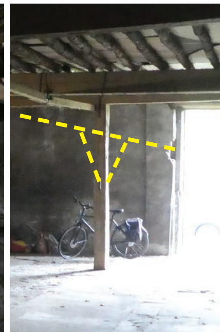
Hoogte van kioppelbalen zijn in de kopgevels zichtbaar aan de lege opleg-plek.
