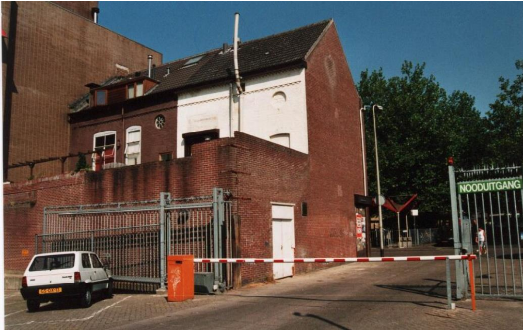
Figuur 3.13. Achterzijde van de Tuinstraat nummers 14 en 16 in 1995. Na de sloop van nummer 12 is een klampmuur tegen de zijgevel van nummer 14 geplaatst. Het achtererf is door middel van een hoge muur gescheiden van het V&D-terrein (Bron RAT beeldarchief foto 033579).
