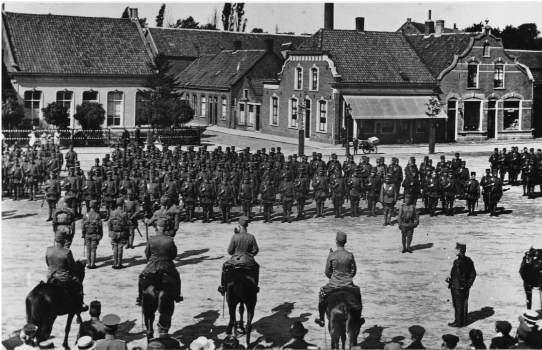
Figuur 3.47. Emmastraat vanaf het Piusplein. De foto is genomen tijdens de mobilisatie in de Eerste Wereldoorlog. Van gebouw 8 is alleen het dak en een klein deel van de kopgevel te zien, achter de lage huizen van de Emmastraat (nummer 3 is het pand met noklijn parallel aan de straat). Op deze foto is de schoorsteen van de fabriek van Goyarts nog te zien, boven de noklijn van het hoekpand met zonneluifel (bron: Beeldarchief RAT foto 028591, bewerkt).
