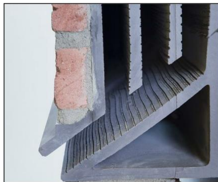
Figuur 7. Detail van afwerking van een ingemetselde kraamkast van het type Tichelaar.
