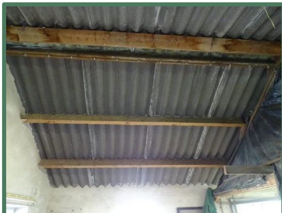
Onderzijde dak steense schuur
