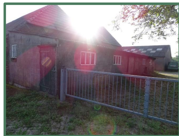
Te slopen aanbouw rundveestal
