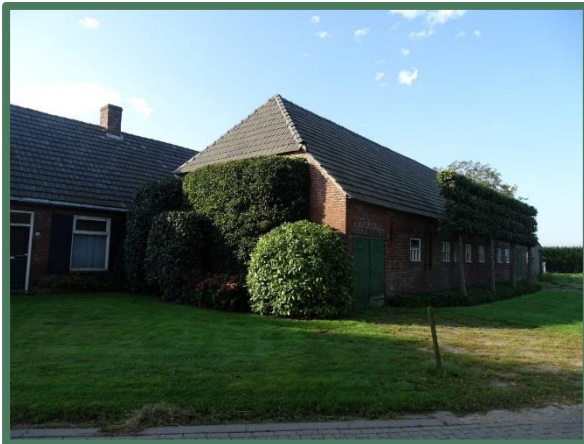
Straatzijde woonhuis en rundveestal
