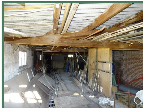
Onderzijde dak aanbouw rundveestal
