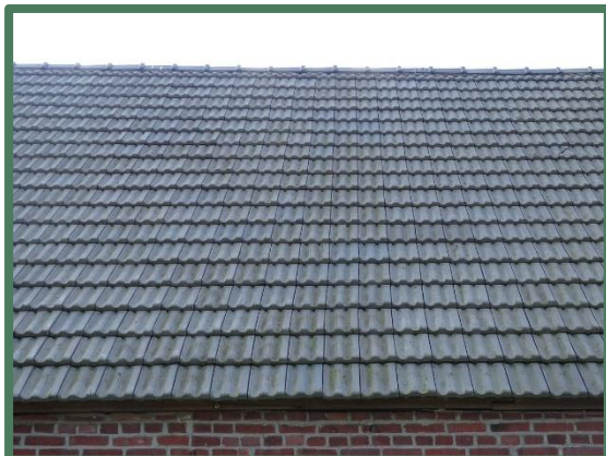
Geen losse of gebroken dakpannen
