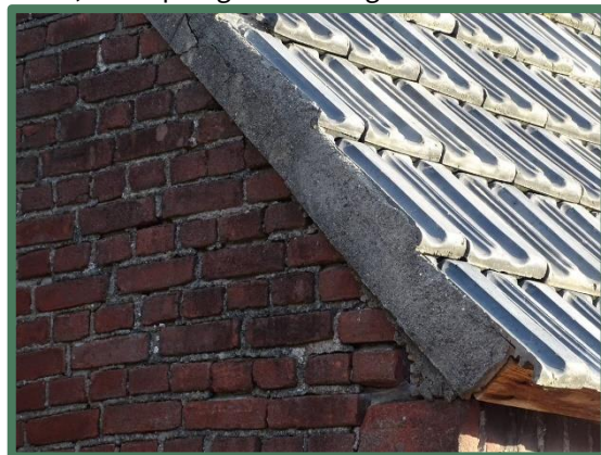
Dichtgemetselde kopgevel
