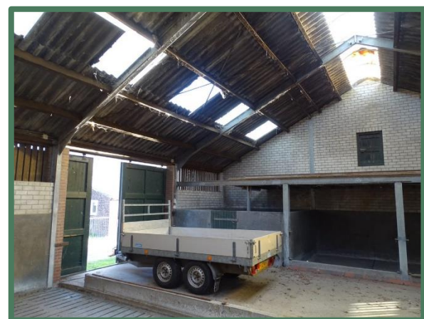
Binnenzijde te behouden loods
