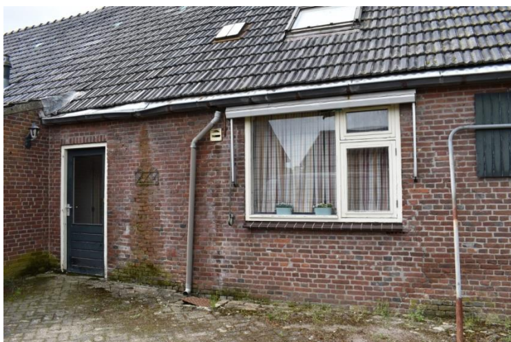
Vernieuwd venster en deur in achtergevel.
