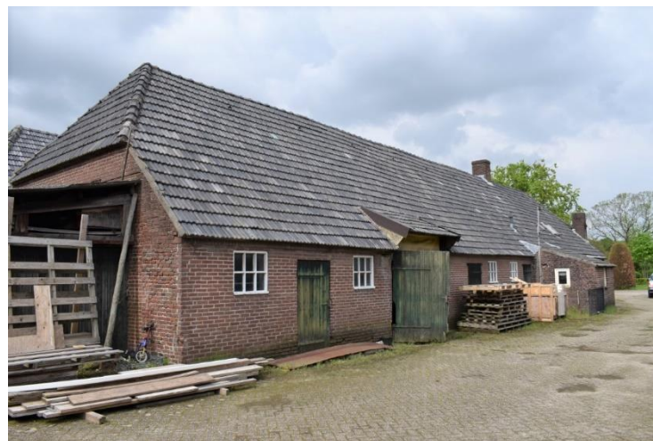
Achtergevel van het bedrijfsgedeelte van de boerderij.
