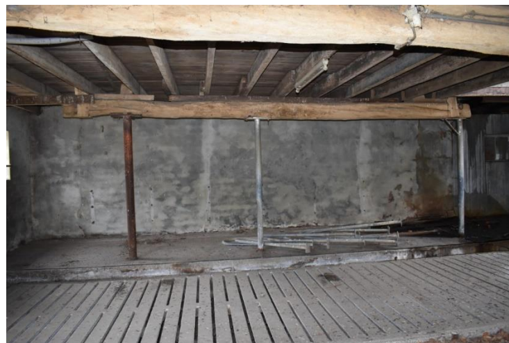
Restant van een ankerbalkgebint in het bedrijfsgebouwe.
