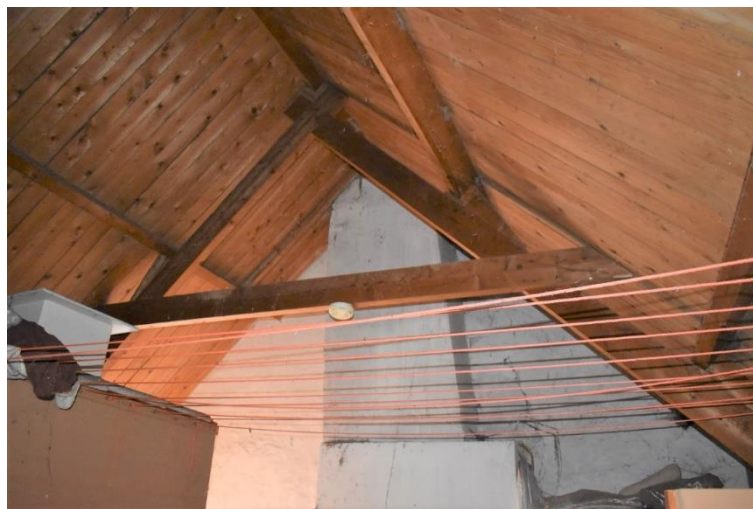
In het midden van de 20 ste eeuw vernieuwd spant.
