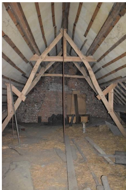
Oorspronkelijk schaarspant.
