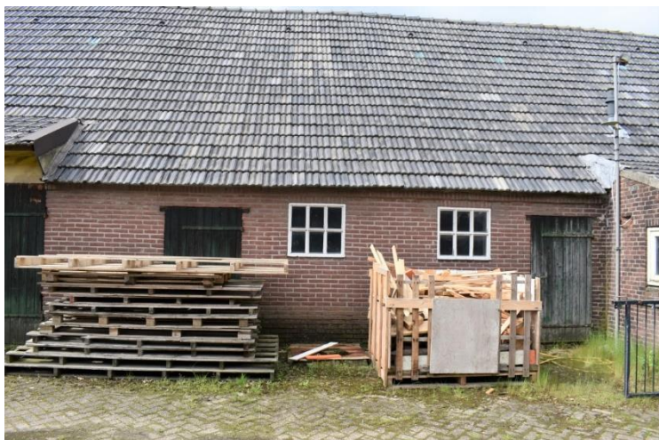
Rechter deel van in 1969 opnieuw opgetrokken achtergevel.
