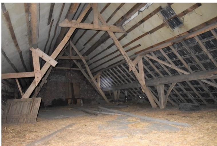
Oorspronkelijk schaarspant boven het bedrijfsgedeelte.
