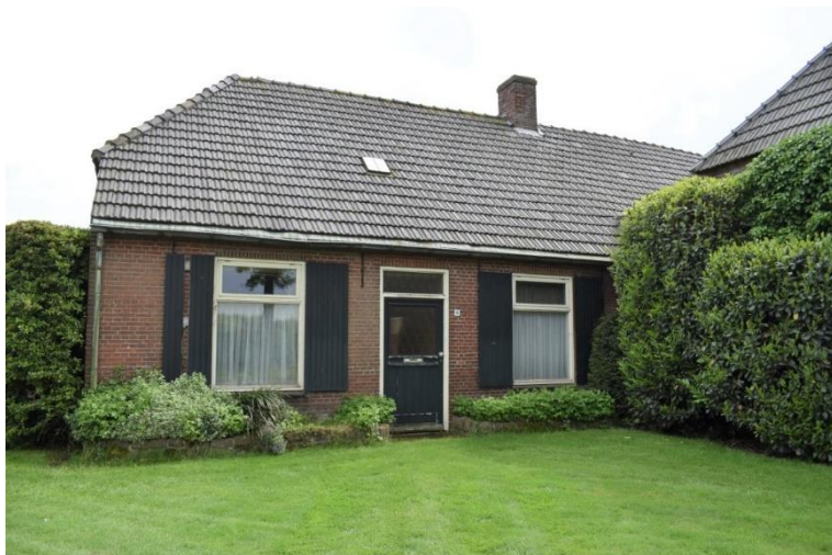
Voorgevel van het woongedeelte van de boerderij.
