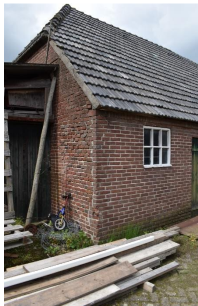
Oorspronkelijk metselwerk uiterst rechts in de rechterzijgevel.
