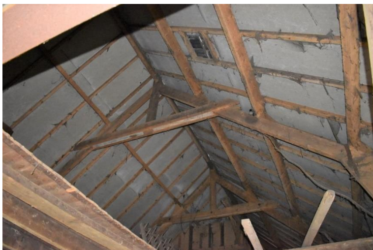
Nokstijlsanten in het in 1912 aangebouwde bedrijfsdeel.
