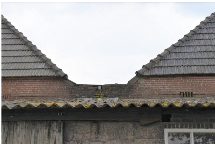
Oorspronkelijke rechterzijgevel boven de aanbouw.
