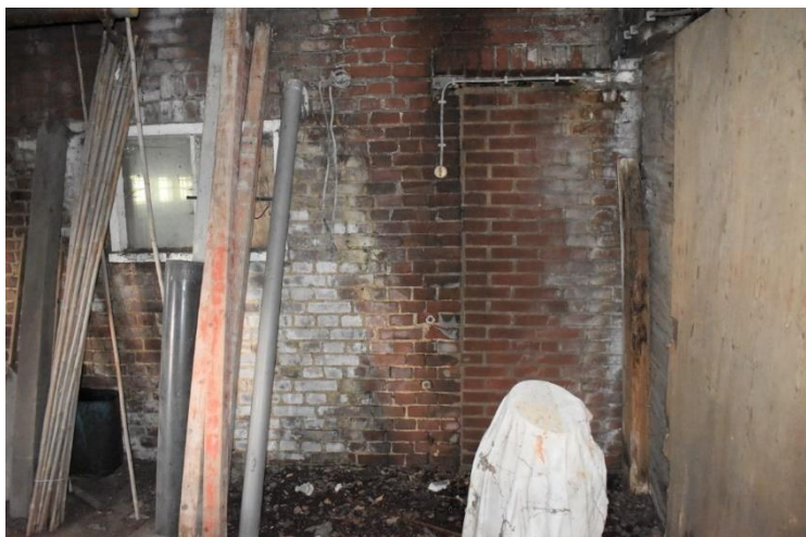
Dichtgemetselde deuropening in rechterzijgevel.
