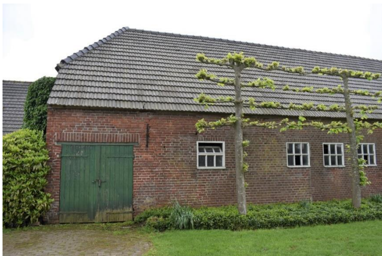
In 1969 aangebrachte deur in bedrijfsgedeelte.
