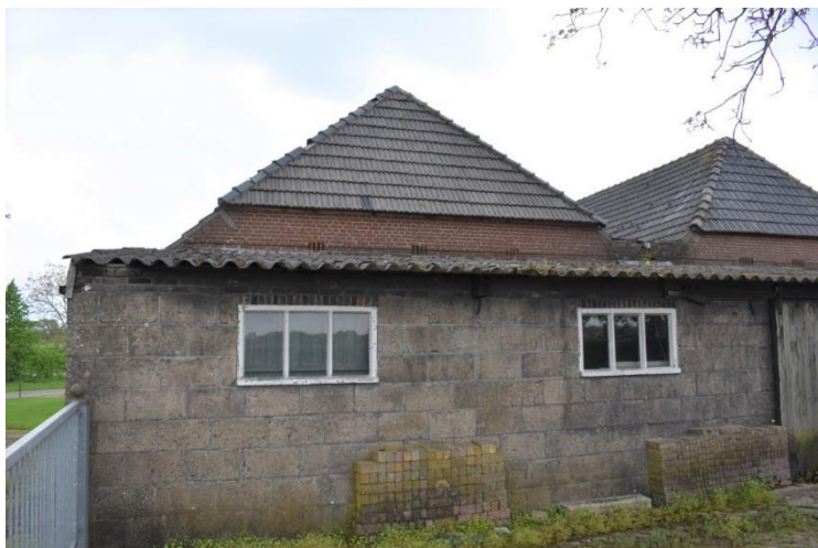
Aanbouw tegen rechterzijgevel.
