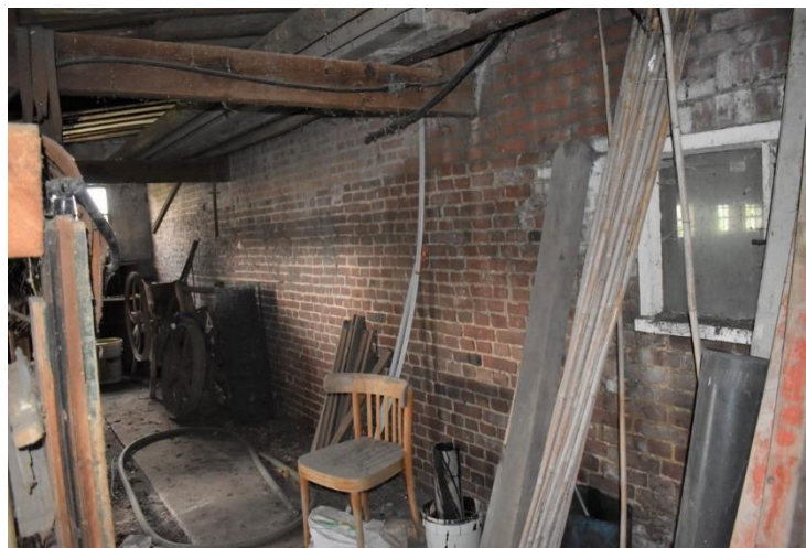
Oorspronkelijke rechterzijgevel binnen in de aanbouw.
