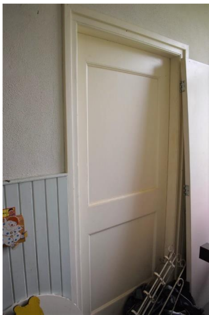
Oorspronkelijke paneeldeur in oorspronkelijk kozijn.
