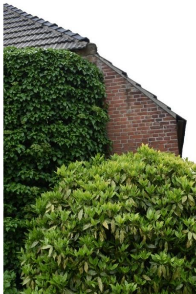
Detail oorspronkelijk metselwerk.
