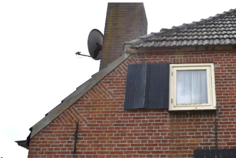
Vlechtingen in metselwerk en vernieuwd venster met schijnluik.
