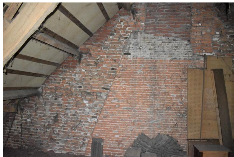
Oorspronkelijke brandmuur met rookkanaal.
