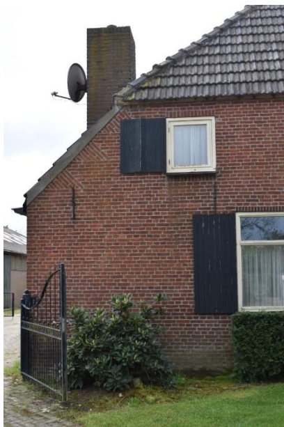
Linker deel van linkerzijgevel.
