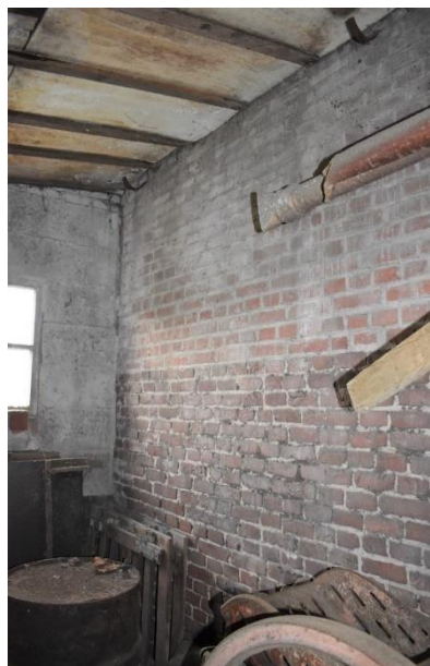
Oud (onder) en nieuw (boven) metselwerk binnen in de aanbouw.
