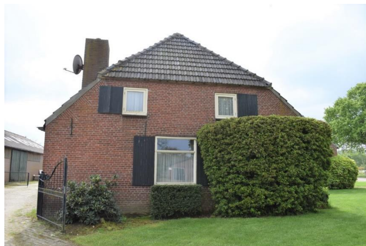
Linkerzijgevel van het woongedeelte.
