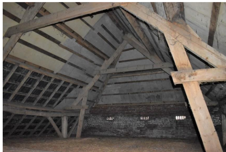
Vernieuwde schaarspanten boven het bedrijfsgedeelte.
