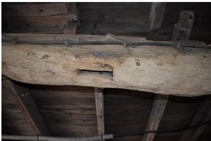
Sporen van de oorspronkelijke constructie in de ankerbalk.
