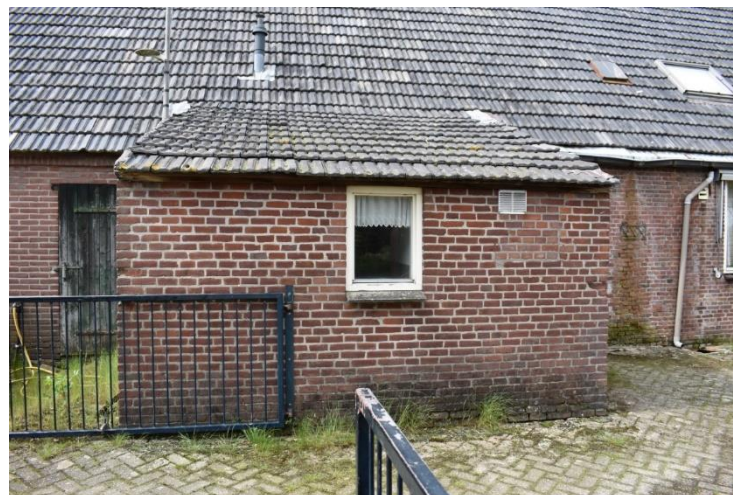
Achtergevel van aanbouw tegen bedrijfsgeboude.
