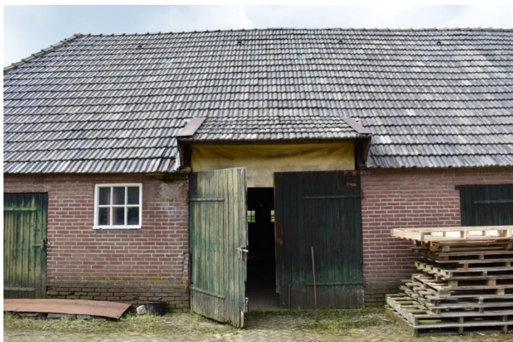
Later opgetild dak boven dubbele staldeur.
