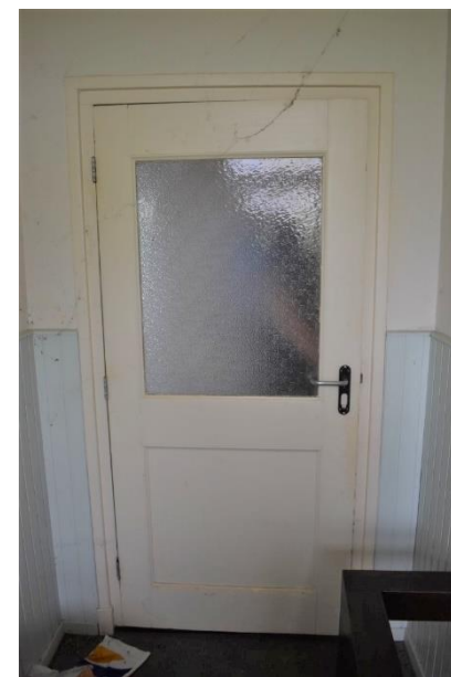
Oorspronkelijke paneel deur waarin glas is gezet.
