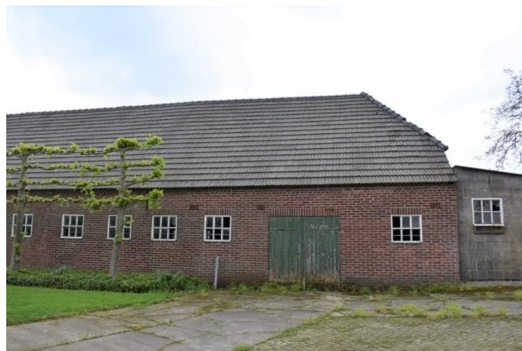
In 1969 opnieuw opgetrokken deel van de voorgevel.
