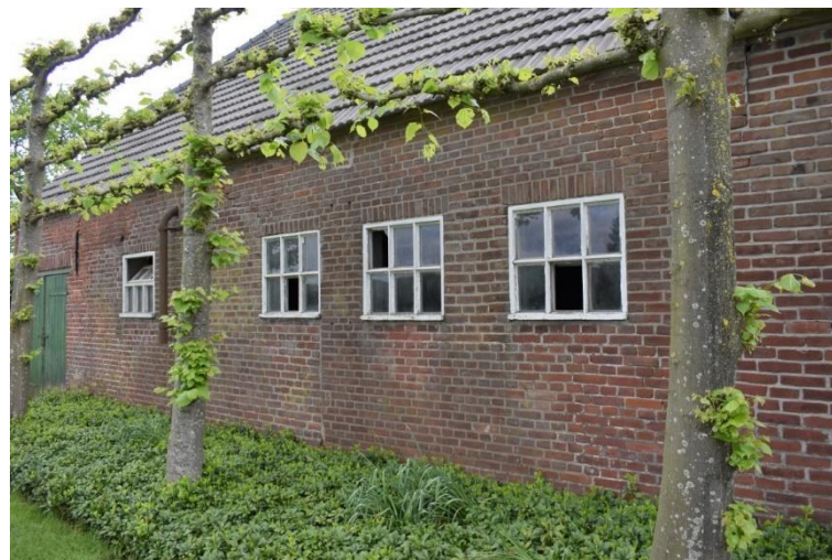
Oorspronkelijk metselwerk met in 1969 gewijzigde indeling.
