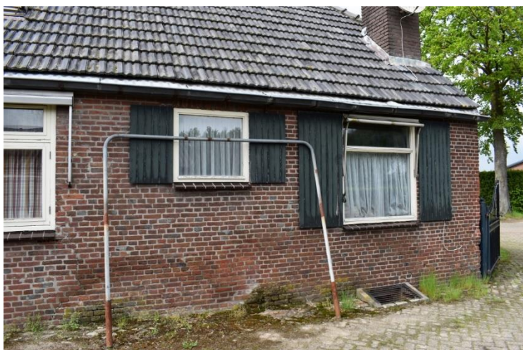
Vernieuwde vensters in achtergevel van het woongedeelte.
