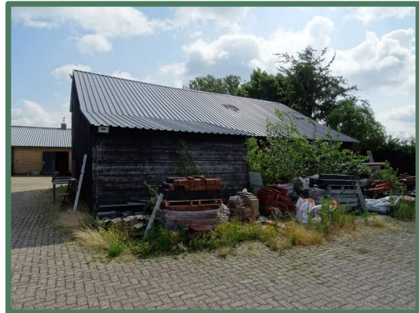
Achterzijde te slopen stal
