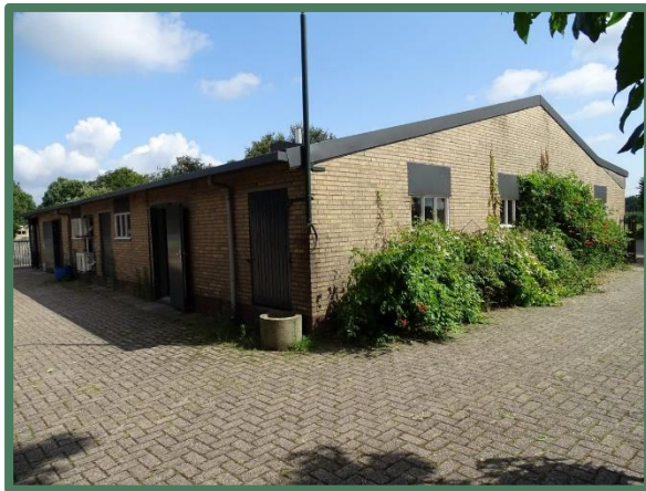
Te behouden gesloten schuur
