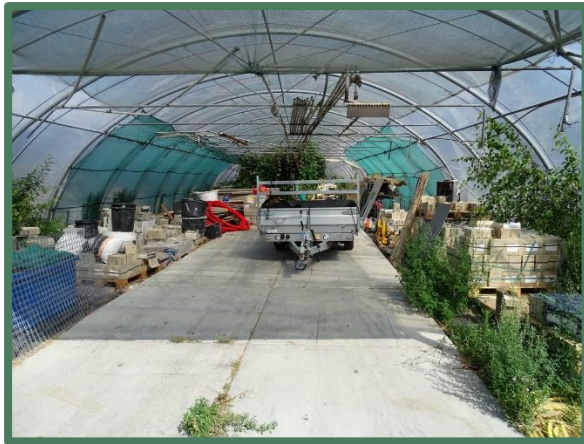
Binnenzijde te slopen windtunnel
