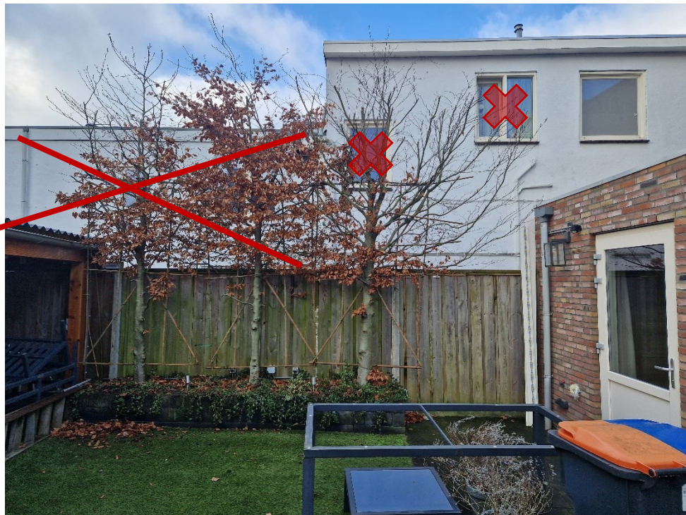
Afbeelding: achtertuin Vendeliersstraat 81 met zicht op Vendeliersstraat 79. De te slopen aanbouw en de gevelopeningen die verdwijnen in het nieuwe plan zijn aangekruist.
