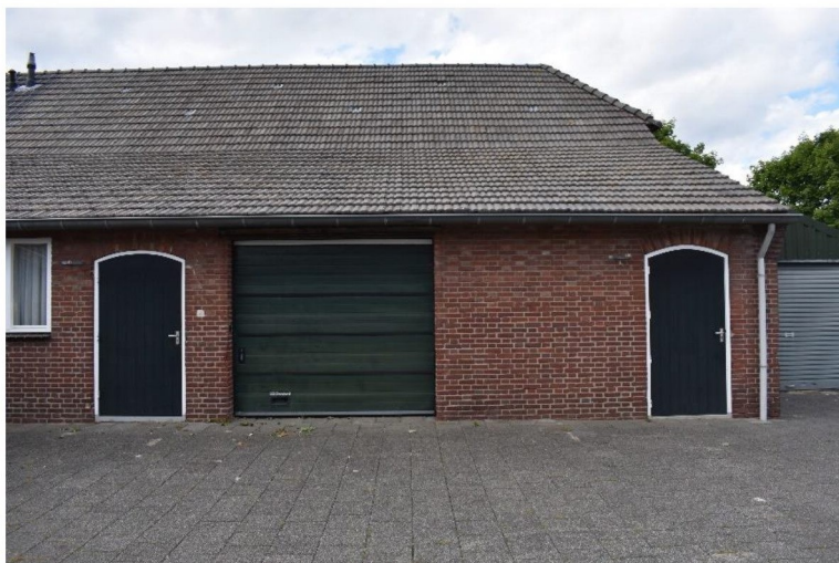
Vernieuwde deuren in het bedrijfs gedeelte.
