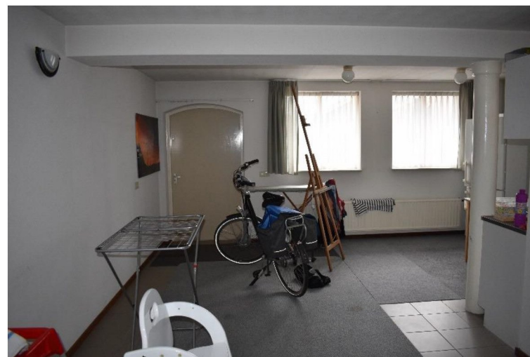
De voormalige schuur.
