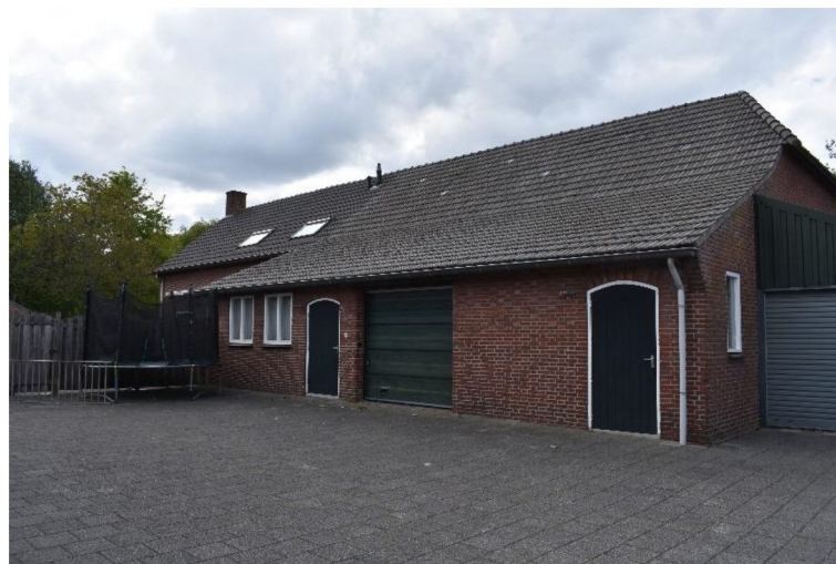
Achtergevel van het bedrijfsgedeelte.
