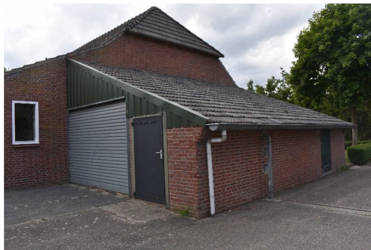
Aanbouw tegen linkerzijgevel.
