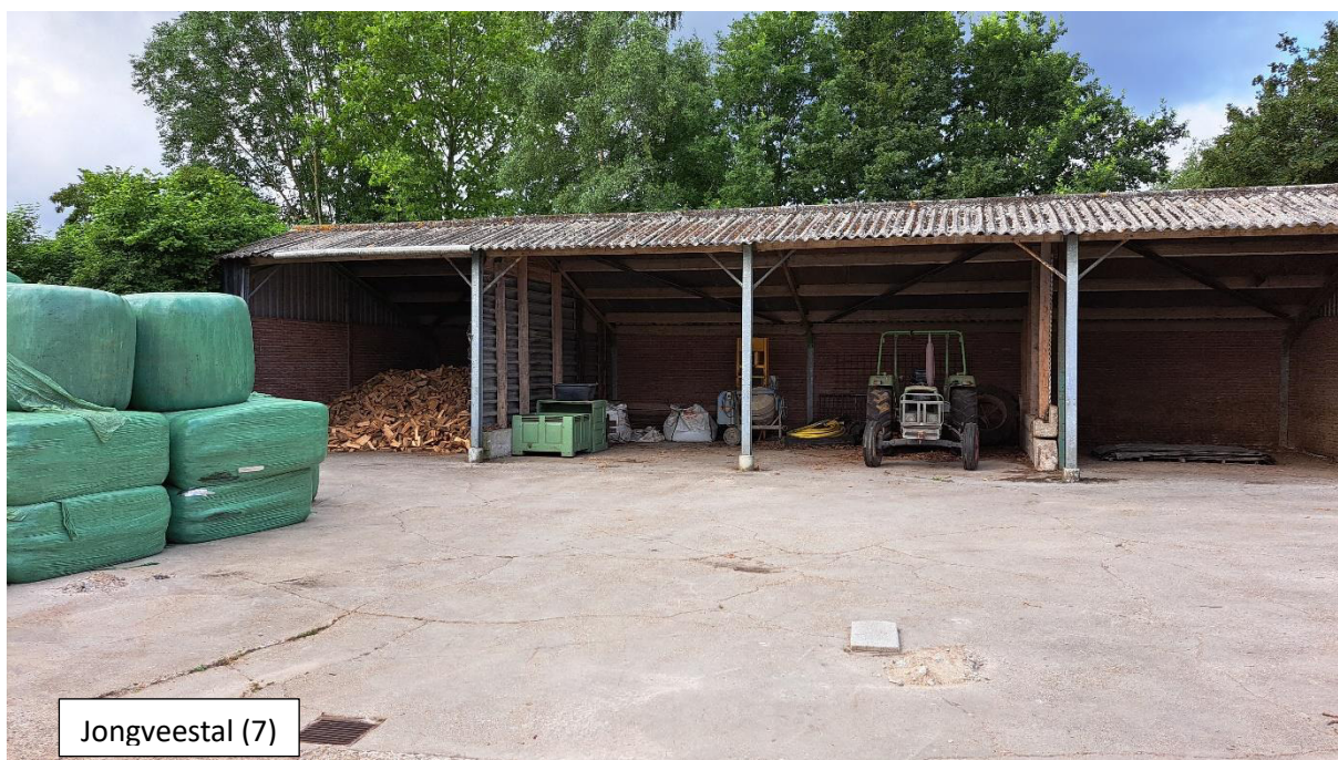
Ten westen van caravanstalling (3)
