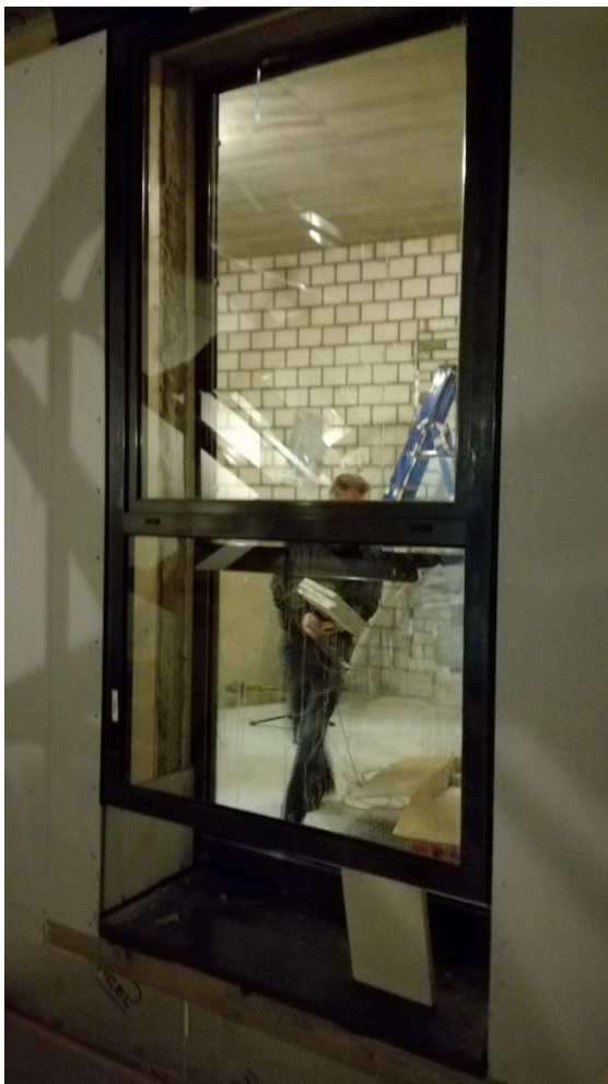
Kozijn buitengevel (meetkamer 3)
