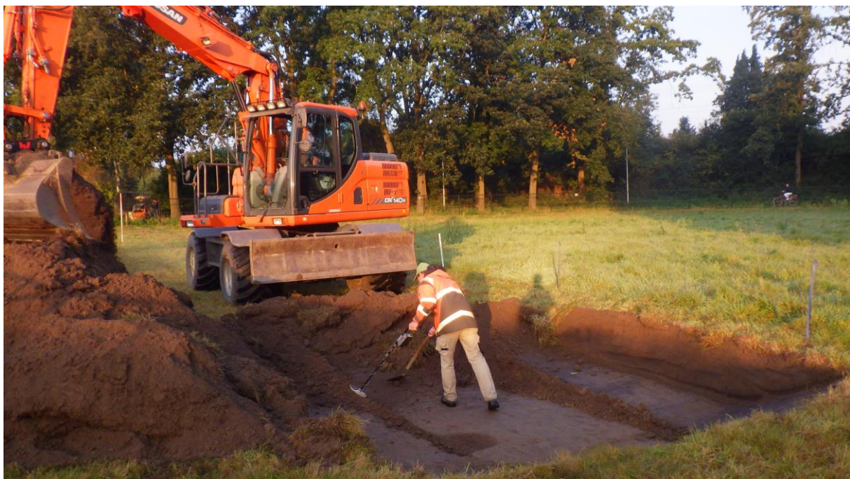
Fig. 1.2. Tilburg-Oud Lovenstraat. Aanleg van het eerste vlak.
