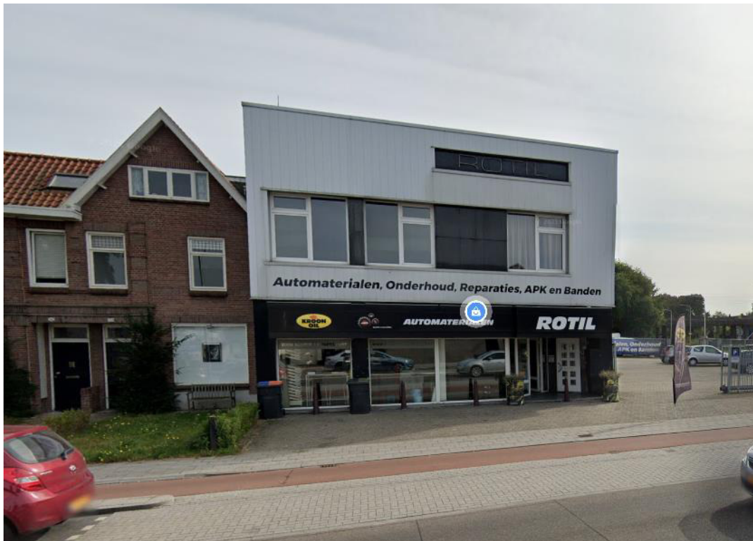
Figuur 3.9: bestaande locatie, gezien vanuit de Bosscheweg, straatzijde.
