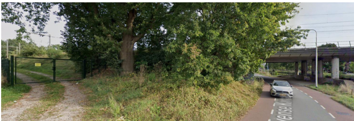
Figuur 3.13: spoor(-viaduct) in zuidelijke richting.
