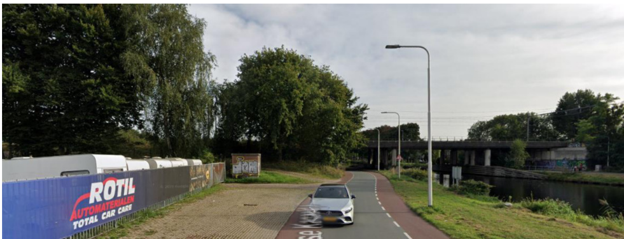
Figuur 3.12: spoor(-viaduct) in zuidelijke richting.
