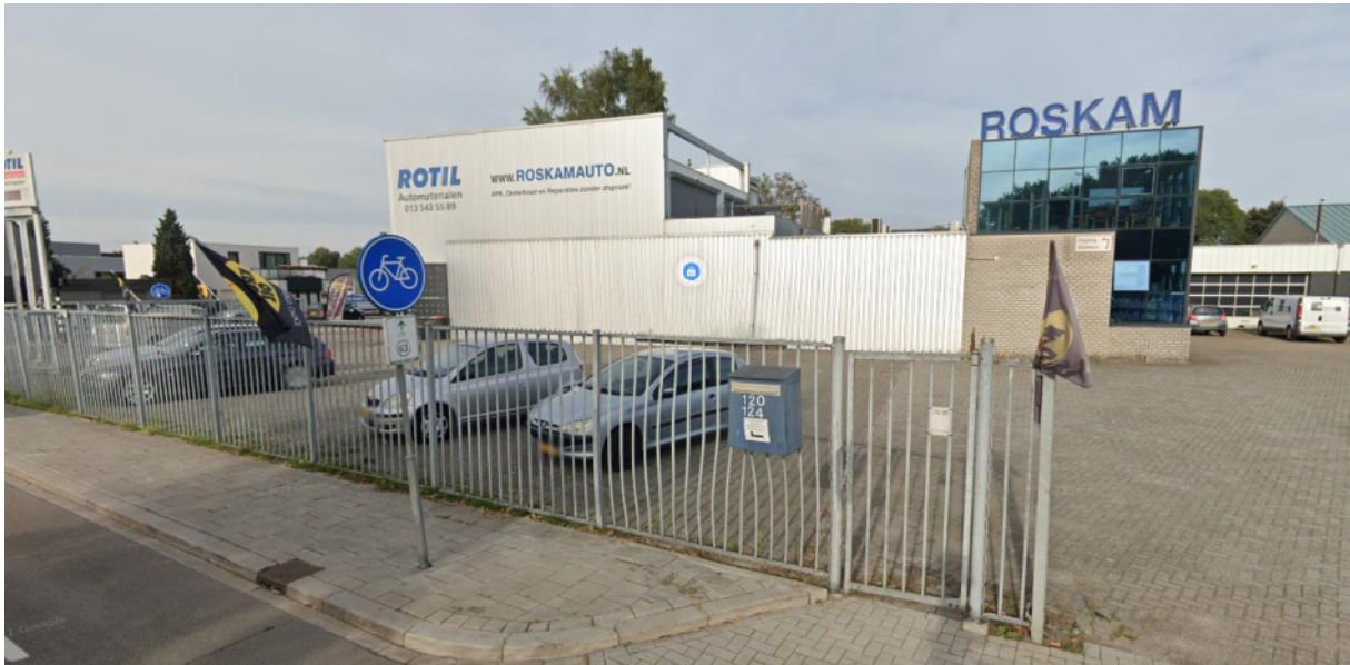
Figuur 3.11: bestaande locatie, gezien vanuit de Bosscheweg, rechter zij-aanzicht.
