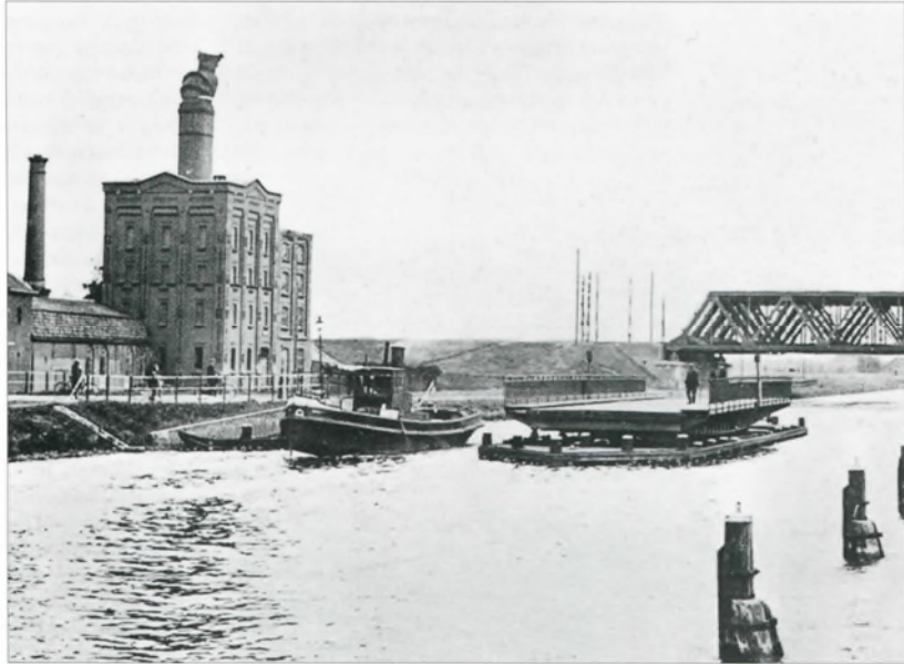
Afbeelding 12: Wilhelminakanaal ter hoogte van de Bosscheweg in 1928 (bron: opdrachtgever).
