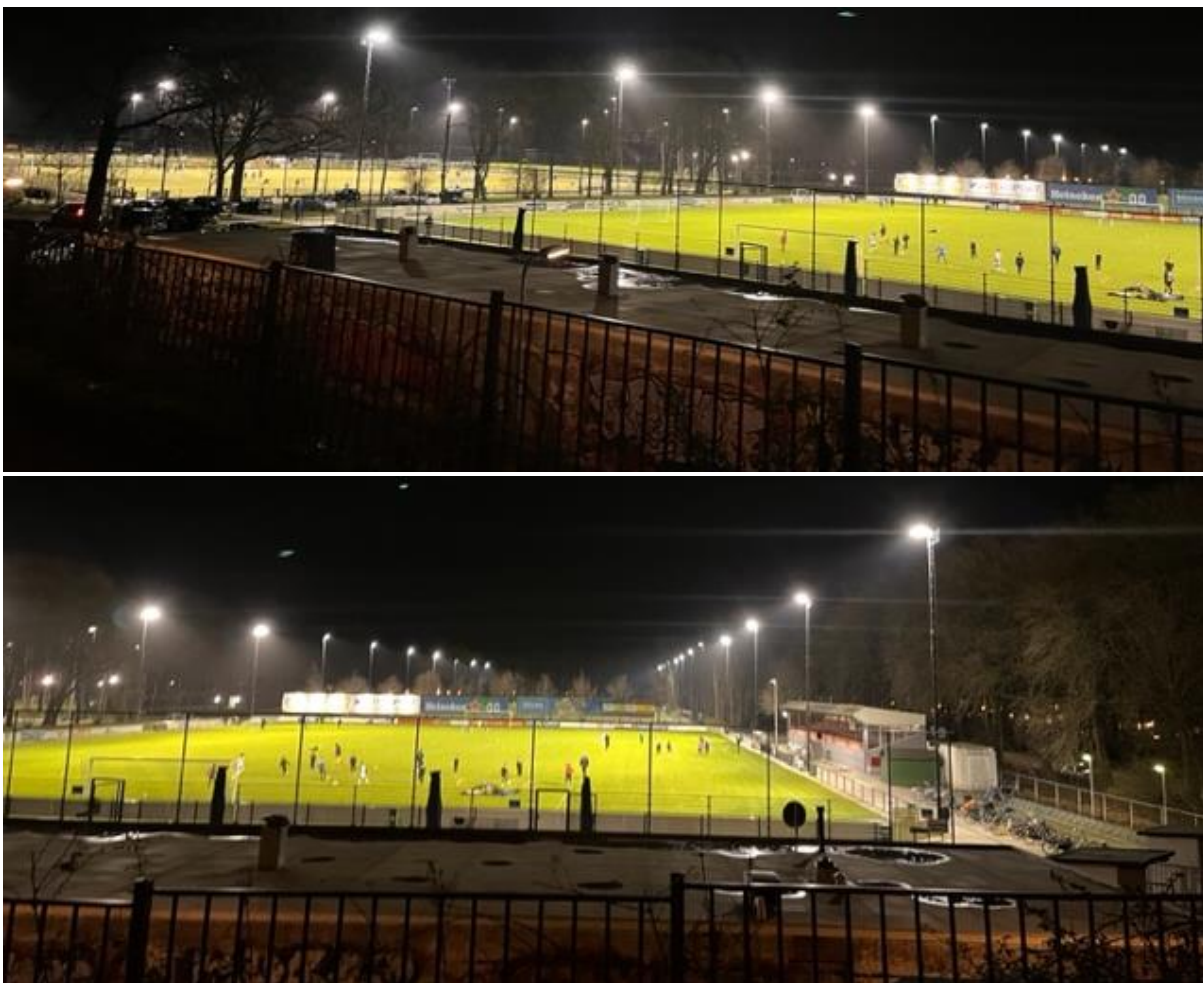
Figuur 1: Foto's van de lichtarmaturen/masten van FC-Tilburg
