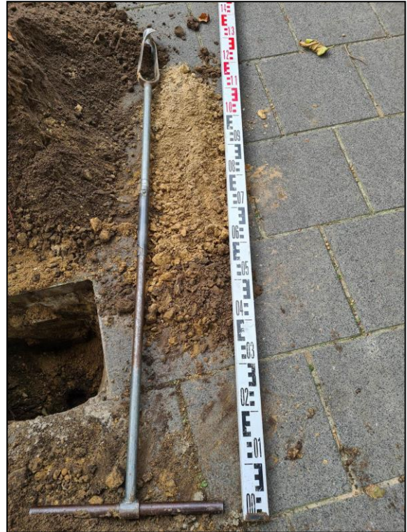
Profielboring ter hoogte van profielsleuf 2.
