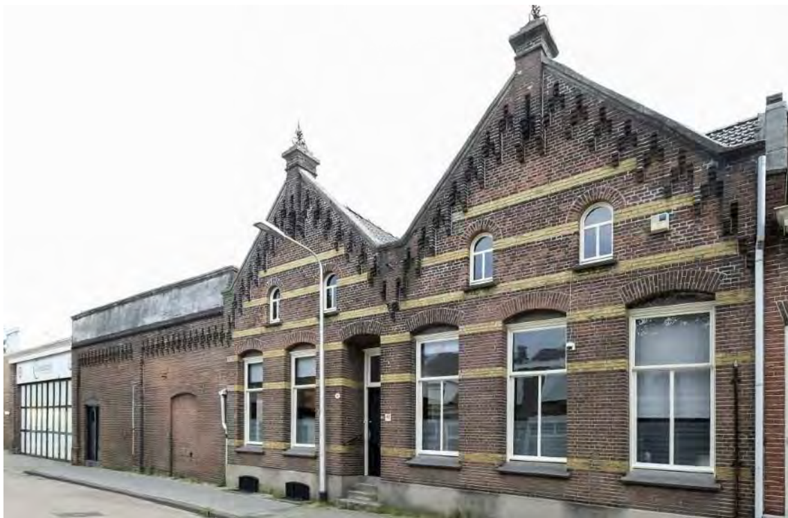
Figuur 2.10: De gevels van Stedekestraat 46 (links) en 48 (rechts) zoals deze momenteel aanwezig zijn. (Bron: Google).
