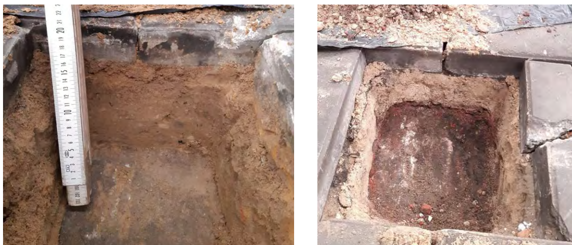
Figuur 3.2: Twee voorbeelden van de ondoordringbare oude vloer die in boring 4, 5 (links), 6 en 8 (rechts) werd aangetroffen. In alle gevallen werd dit vloerniveau gescheiden van de huidige vloer door ca. 20 cm bouwzand met puinfragmenten.
