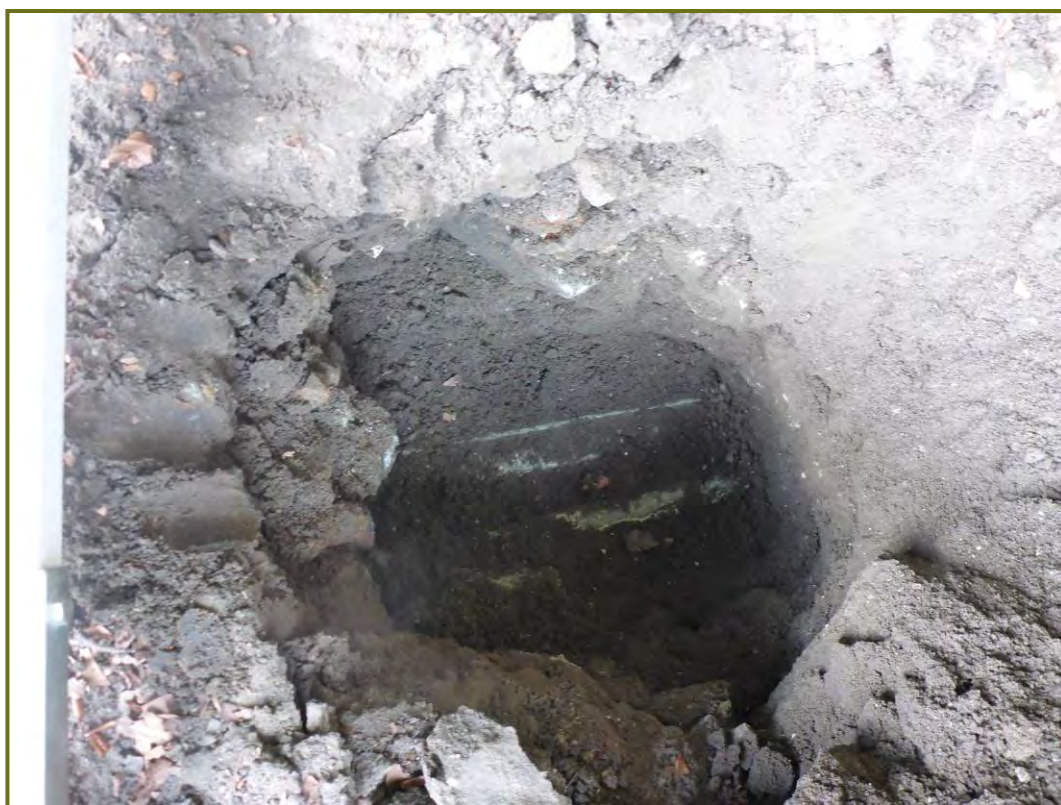
Afbeelding 8. Grote stukken beton
