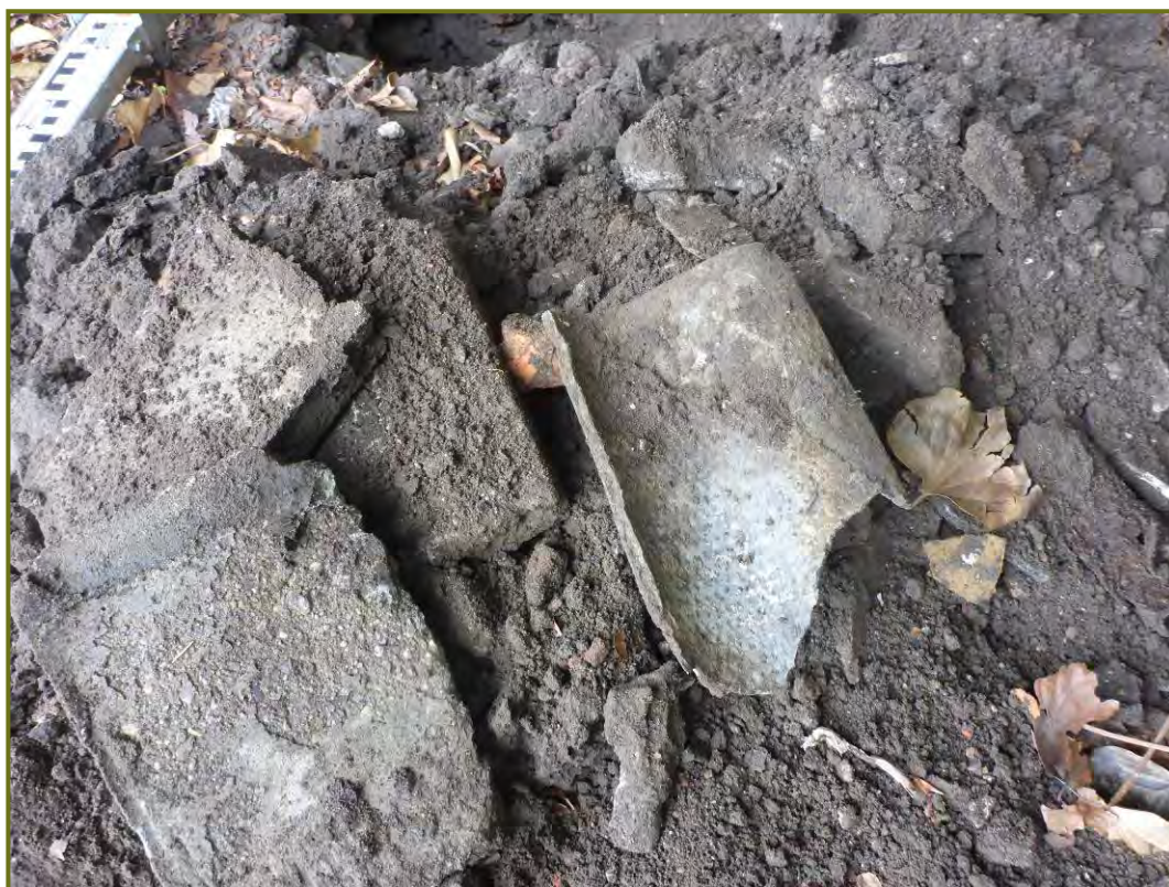
Afbeelding 9. Veel puin en mogelijk restanten asbest
