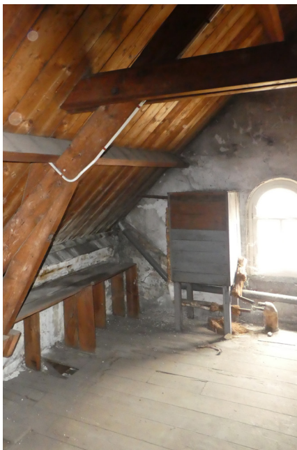
Zolder 1.02 met in de hoek de behuizing van de oude verwarmingsinstallatie, strohulzen zijn als isolatie gebruikt.
