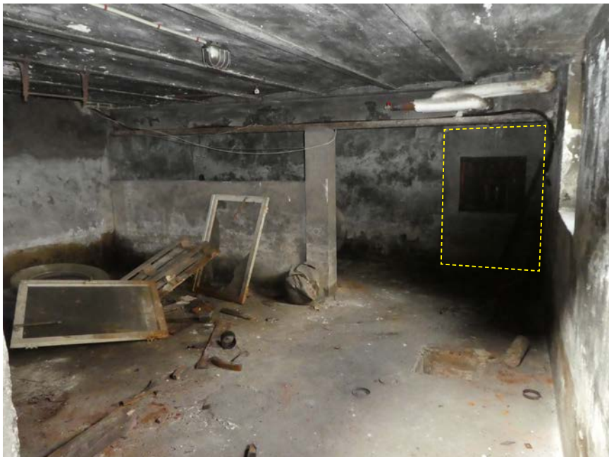
Kelder. Achter de wandverdikking is mogelijk een tweede kelder aanwezig.
