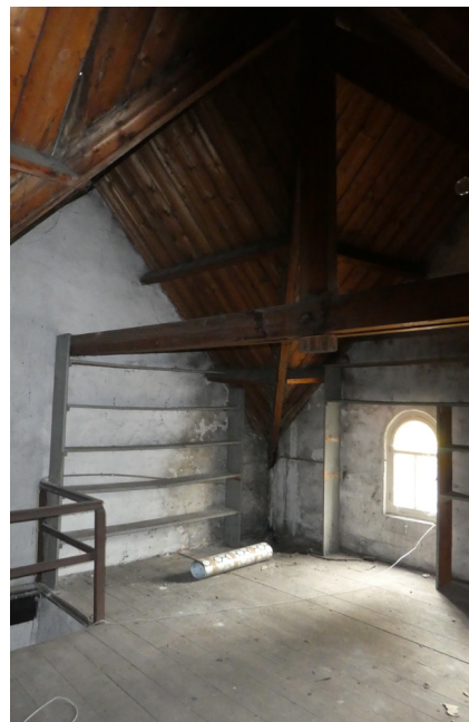
Afwijkend spant bij de samenkomst van de zadeldaken.
