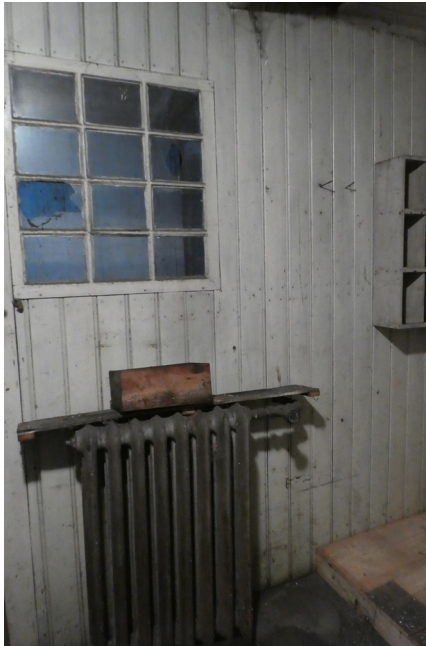
Hergebruikt raam in scheidingswand van kraaldelen.
