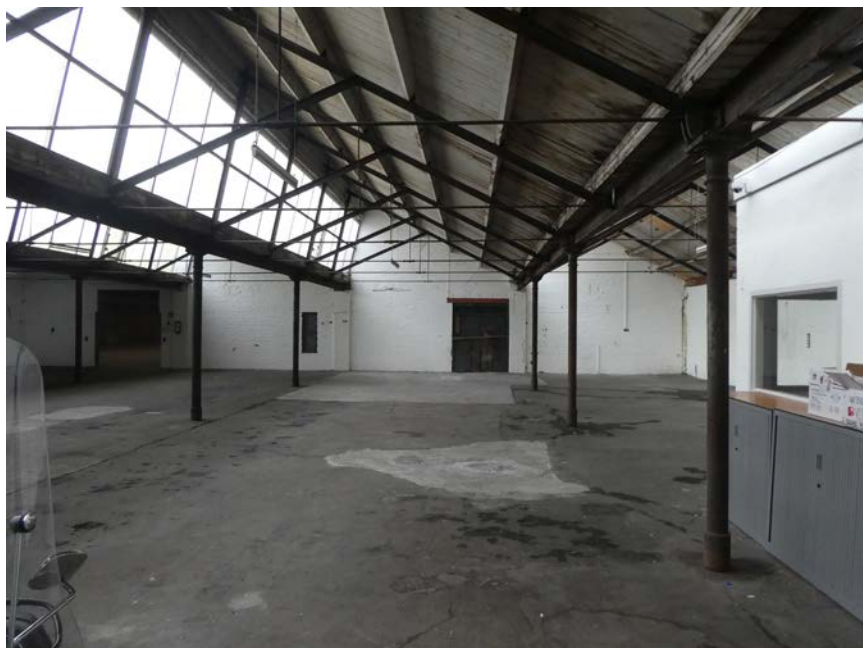
Ijzeren constructie van productiehhal.
