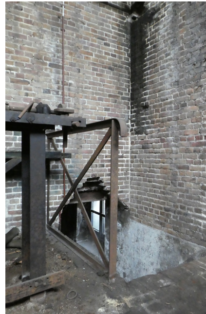
Ijzeren dakconstructie uit 1964.
