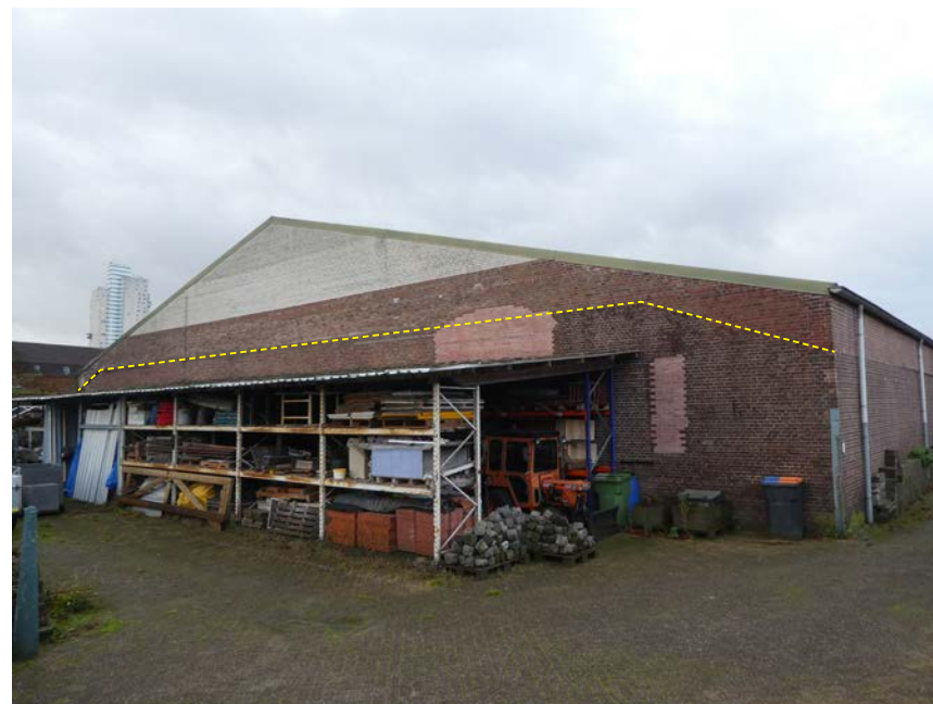
Achter- of oostgevel. De kleuren van het metselwerk duiden op de vroegere daklijn en gevelopeningen.
