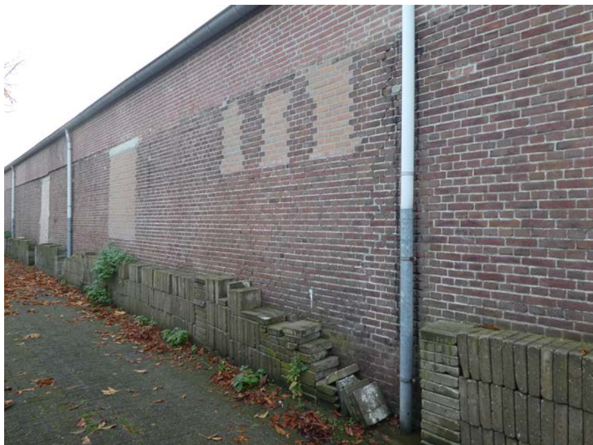
Bouwsporen duiden op gevelopeningen en plaatsen van gevelankers.
