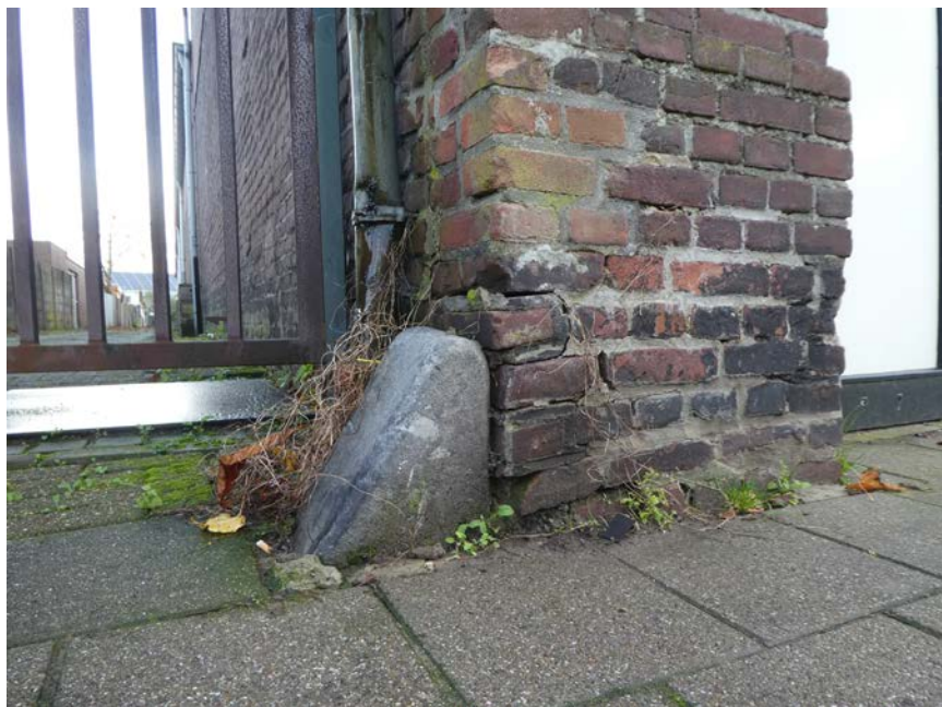
Tegen de hoek en bij de achterste poort zijn de originele hardstenen aanrijblokken herplaatst.
