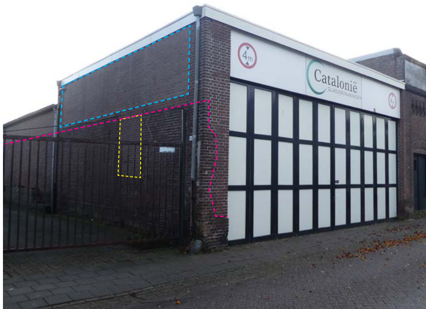
De roze lijn omkadert het metselwerk uit 1917, daarin was een venster aangebracht (geel). In de ophoging uit 1964 was een groot strookvenster aanwezig (blauw.)
