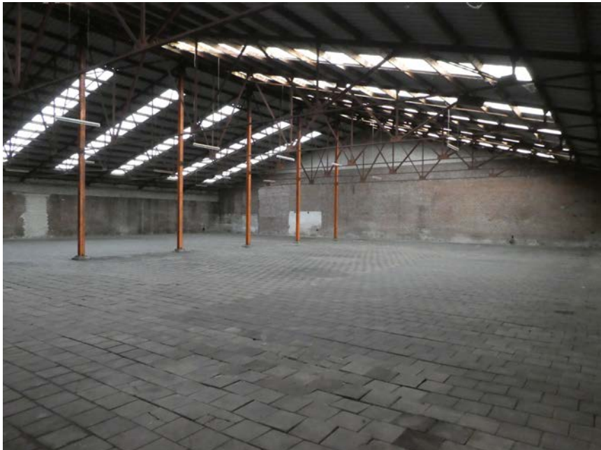
Ijzeren dakconstructie uit 1964.
