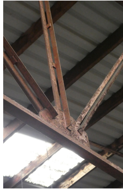
Detail van staalconstructie uit 1964.
