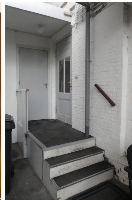
Trap vanuit de productiehal naar kantoor en het toilet. rechts de dichtgezette oude doorgang naar het kantoor.
