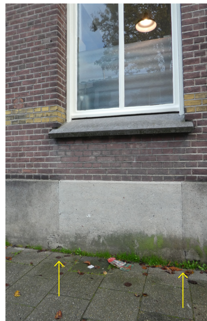
De plint onder het rechter venster vertoont twee bouwnaden.
