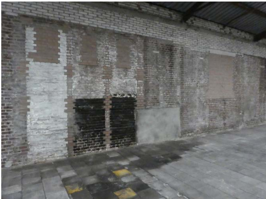
In de noordwand van deze ruimte zijn de drie toiletten met vensters en de naastgelegen urinoirs nog goed te herkennen.
