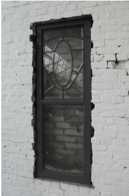
Later ingebracht venster met geslepen en in lood gevat 'spiegelglas'.
