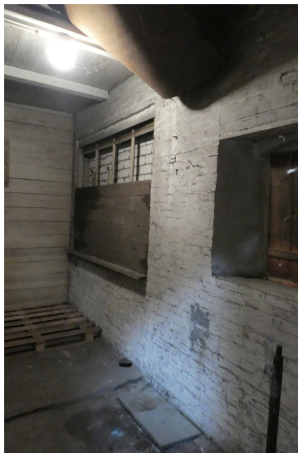
Loketruimte 0.12 met doorbraken waarin hergebruikte oude ramen.
