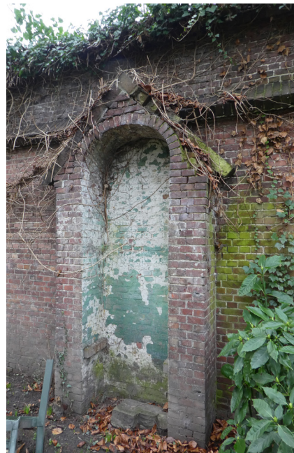
Kapel tegen de westmuur.
