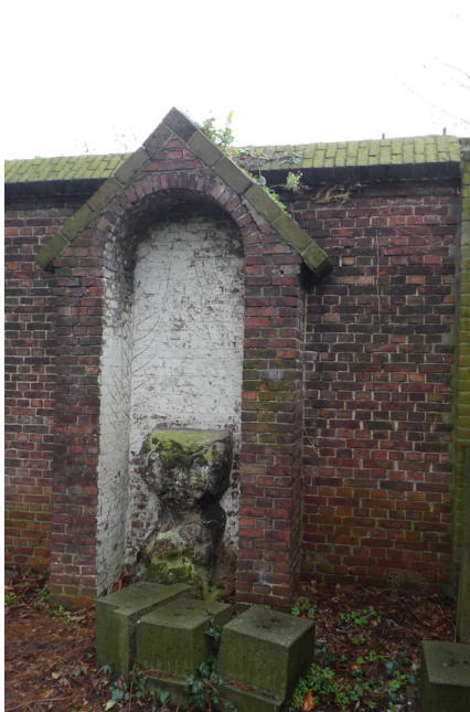
Kapelletje met basement van ijzeroer. Het dakje is met bakstenen gemetseld.
