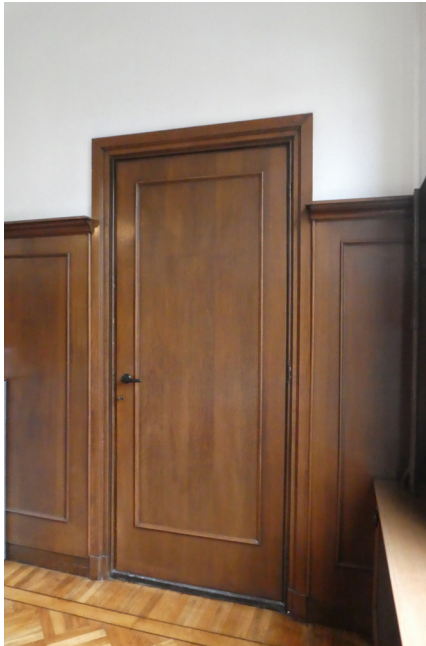
Oude paneeldeur met vlakke plaat.
