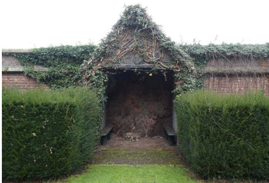
De topgevel van het prieel bestaat uit een houten raamwerk met vulling van kraaldelen.
