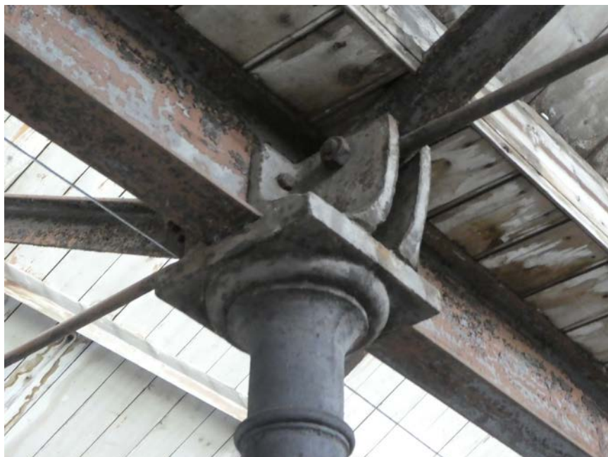
Bovenaansluiting van ijzeren kolommen.
