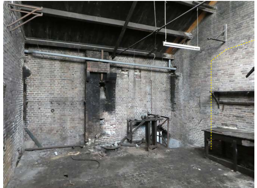
Overzicht van smederij. In de rechter muur is aan de wisseling van het metsel-verband de blindnis te herkennen.
