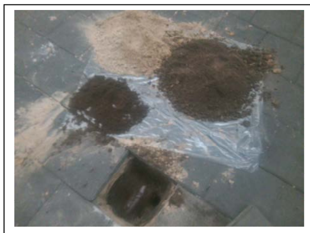
Foto 4. Asbestinspectiegat A04
