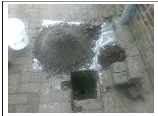
Foto 8. Asbestinspectiegat A08
