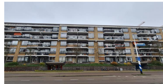
Figuur 5: Appartementencomplex gezien vanaf Piusstraat
