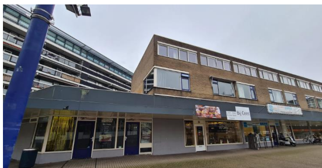
Figuur 7: Enkel laags gedeelte bebouwing met winkels en boven woningen gezien vanaf Koningsplein
