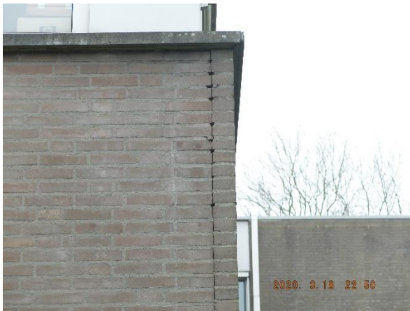
Figuur 11 Open dilatatievoeg en ruimte om onder het dak en achter de gevelbeplating te komen bij de van Limburg Stirumlaan 4 en 6
