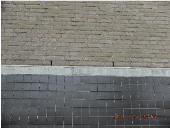
Figuur 10 Open stootvoegen bij van Limburg Stirumlaan 2 en 6
