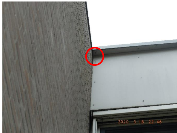
Figuur 11 Open dilatatievoeg en ruimte om onder het dak en achter de gevelbeplating te komen bij de van Limburg Stirumlaan 4 en 6
