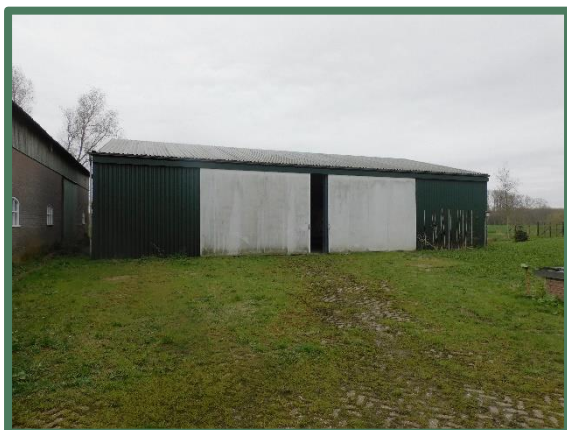
Overzicht voorzijde te slopen loods
