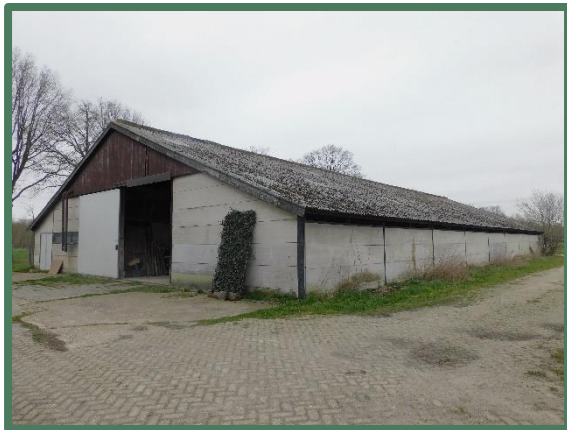
Overzicht ligboxenstal vanaf zuid
