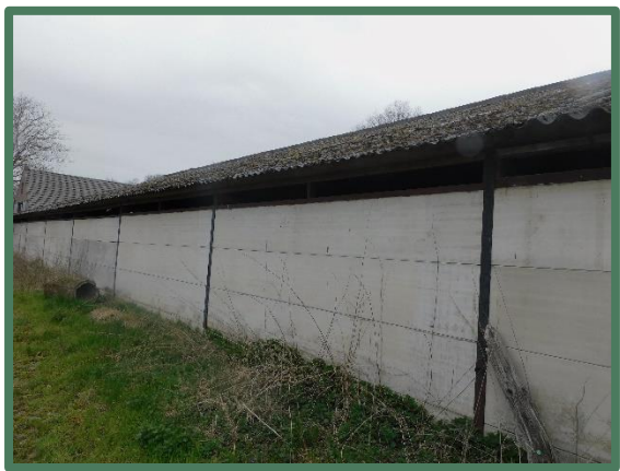
Zijgevel ligboxenstal met luchtinlaat
