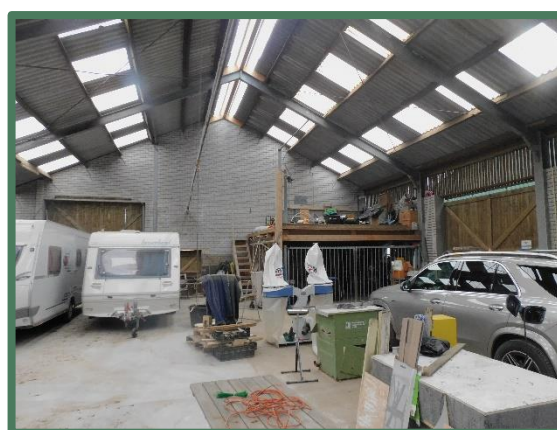
Binnenzijde te behouden schuur
