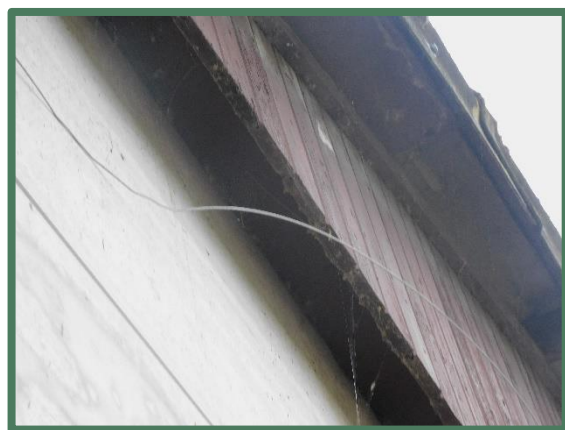
Kopgevel stal buiten
