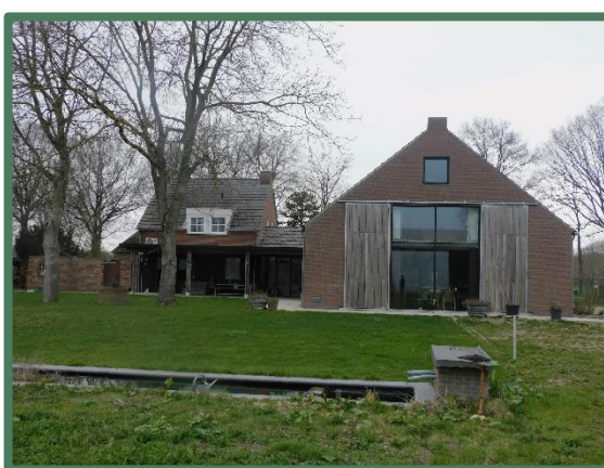
Overzicht achterzijde woning
