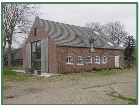
Overzicht aanbouw woning
