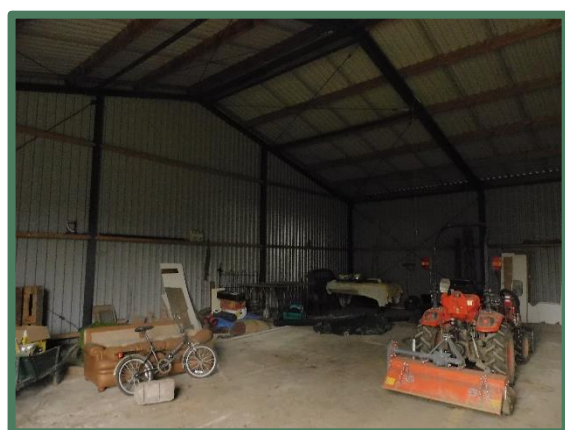
Binnenzijde te slopen loods
