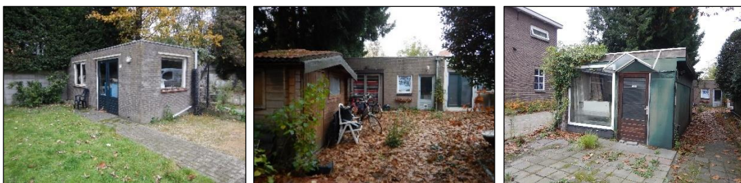
Figuur 8. De drie te slopen gebouwtjes.
