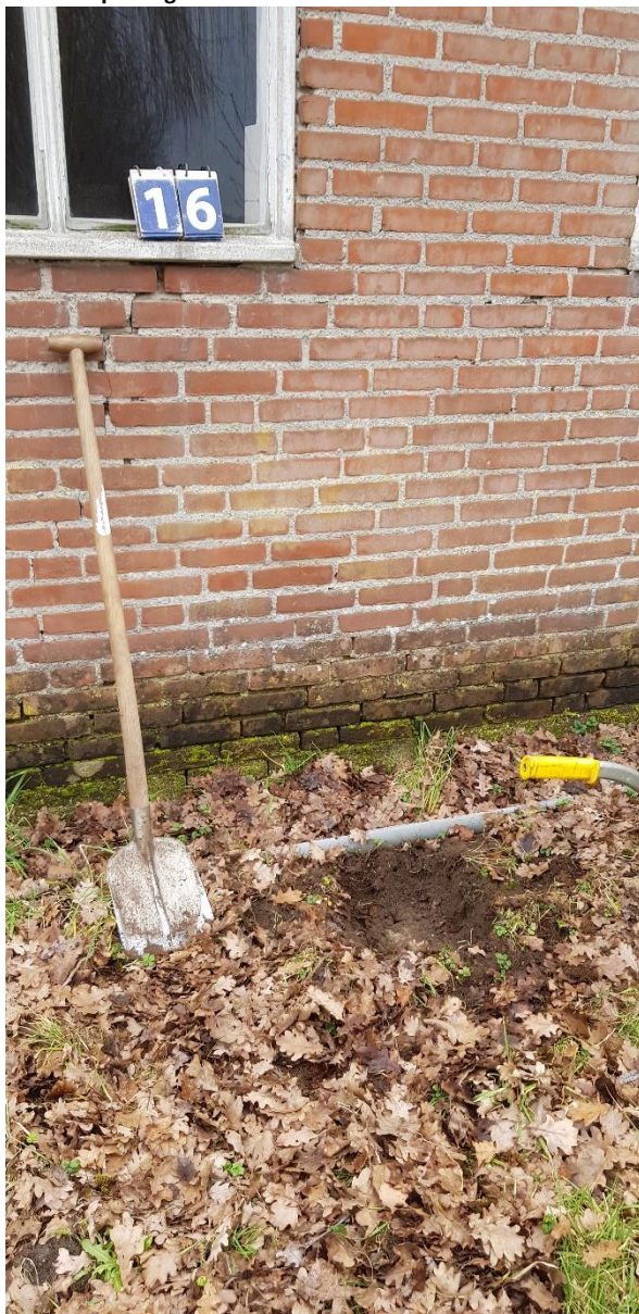
Foto's inspectiegaten en sleuven
