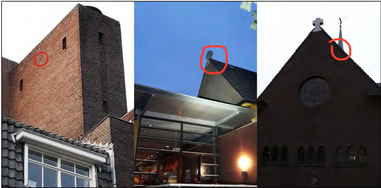
Afb. 6.1.4. In- en uitvliegopeningen van de vastgestelde zomerverblijven van de gewone dwergvleermuis in de westzijde van de toren in de westvleugel (links, rode cirkel, tevens uitvliegopening voor gewone grootoorvleermuis), bovenaan de zuidzijde van de kapel (midden, rode cirkel) en aan de westzijde van de kapel (rechts, rode cirkel).
