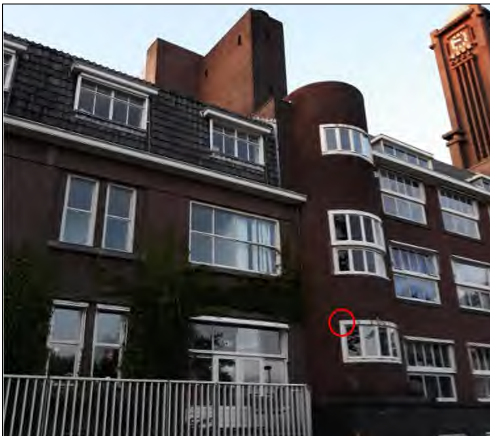
Afb. 6.1.5. In- en uitvliegopening van de vastgestelde paarverblijfplaats van de gewone dwergvleermuis in de westvleugel (rode cirkel).
