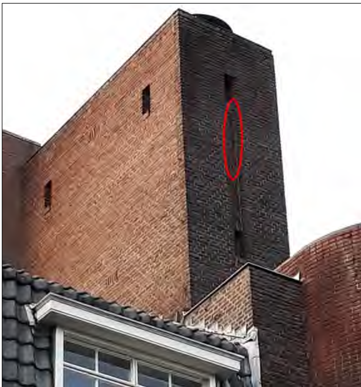
Afb. 6.1.1. In- en uitvliegopening van de vastgestelde zomer- en kraamverblijfplaats van de laatvlieger (rood omcirkeld).
