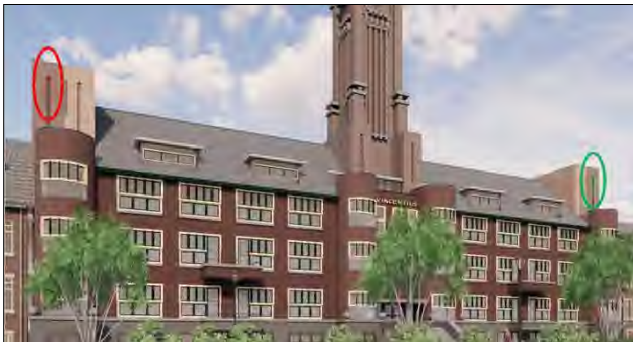
Afb. 10.3.1. Zuidgevel van het hoofdgebouw met de huidige, te behouden kraamverblijfplaats van laatvlieger in de westelijke risaliet (binnenste rode ellips) en de toekomstige verblijfplaats (binnenste groene ellips) in de oostelijke risaliet.
