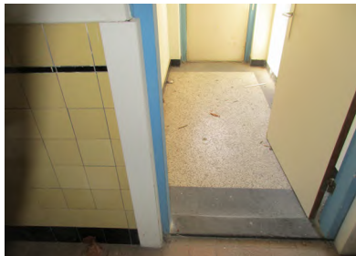
In de terrazzovloer is afleesbaar dat de entreehal/ garderobe oorspronkelijk breder was.
