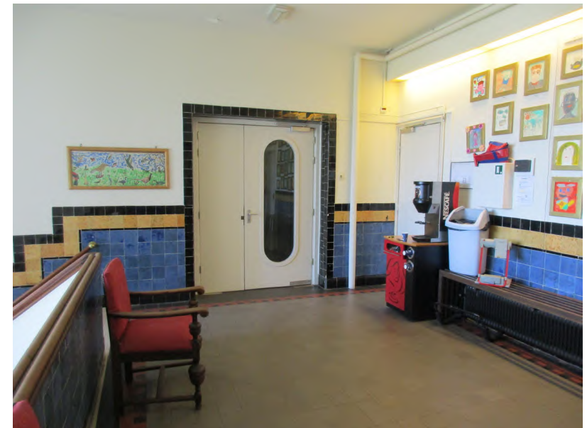
Tegelvloer ter plaatse van het trappenhuis, de doorgang is afgewerkt met tegels.
