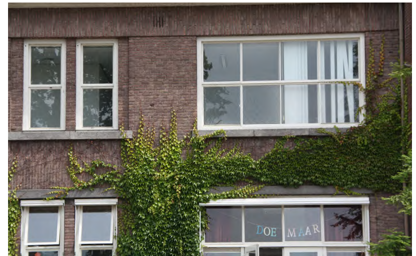
Detail van de in 1945 vernieuwde vensters (vierdeling, stalen ramen)
