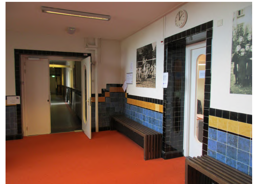
Gang ter plaatse van het trappenhuis, de doorgangen zijn afgewerkt met tegels.
