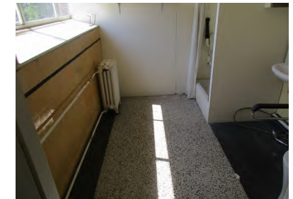
Toiletruimte en aangrenzende kamer
