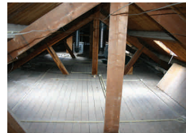
Overzicht van de kapconstructie.
