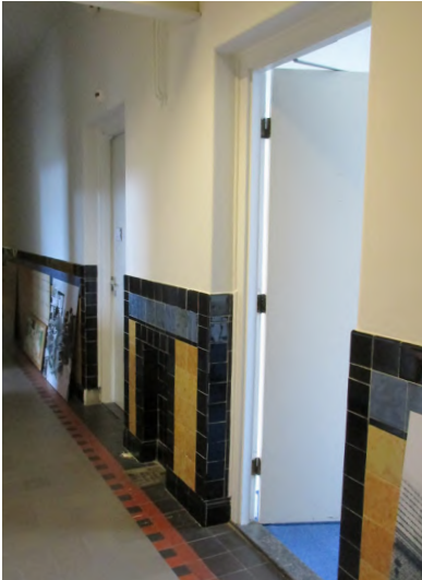
Gang met tegellambrisering en nis, voorheen met stortbak
