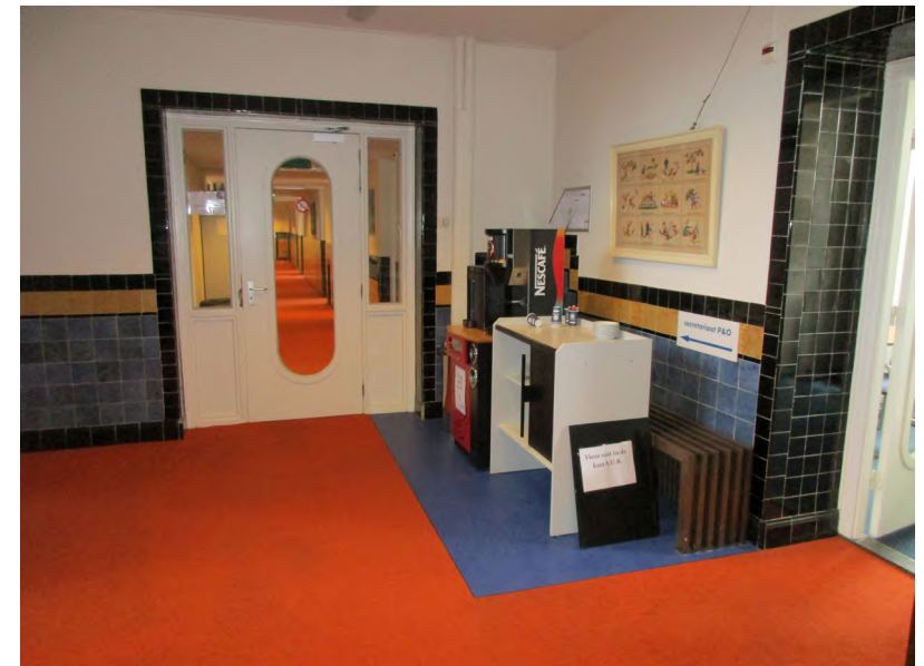
Gang ter plaatse van het trappenhuis, de doorgangen zijn afgewerkt met tegels.
