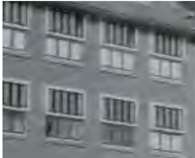
Oorspronkelijk venster (houten draairamen)
