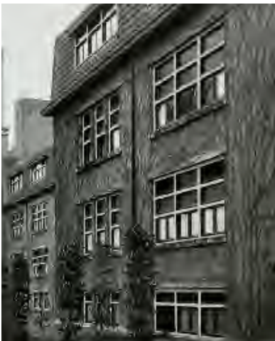
Oorspronkelijke vensters met driedeling en houten ramen.
