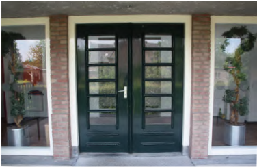
Oorspronkelijke deur in achtergevel
