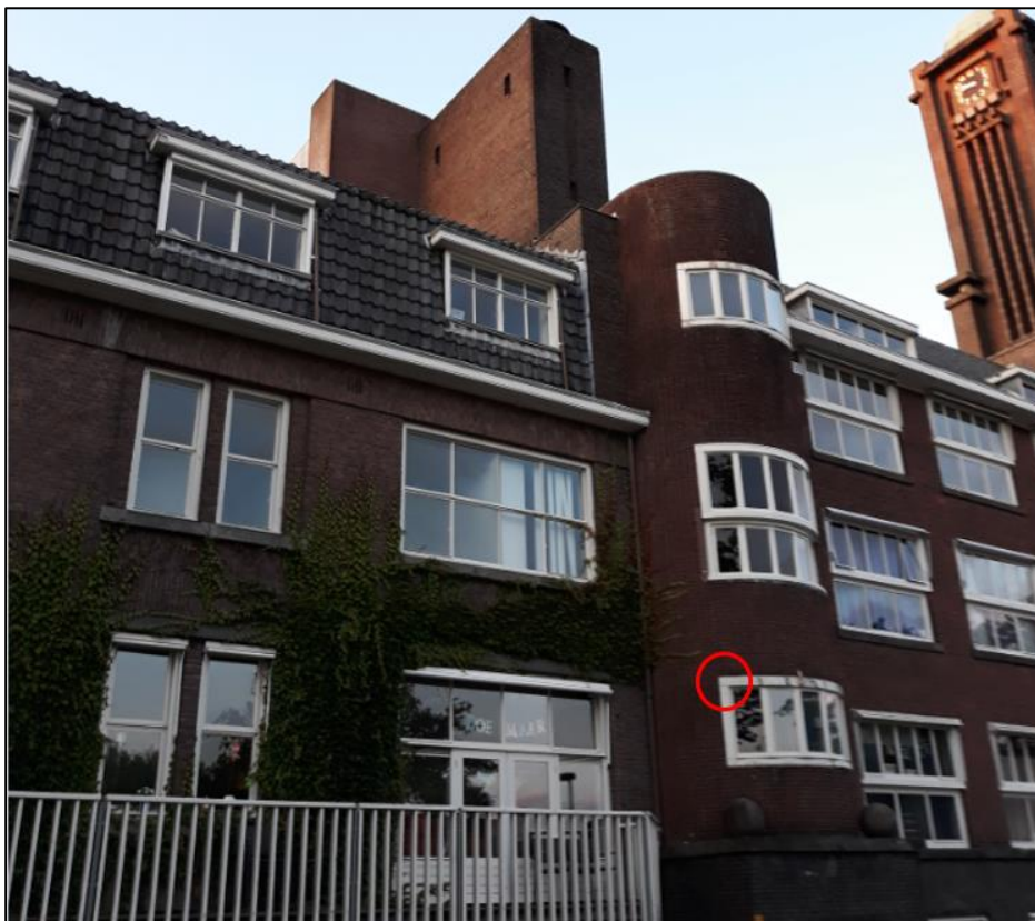
Afb. 3.2.5 Vastgestelde paarverblijfplaats van de gewone dwergvleermuis in de westvleugel.
