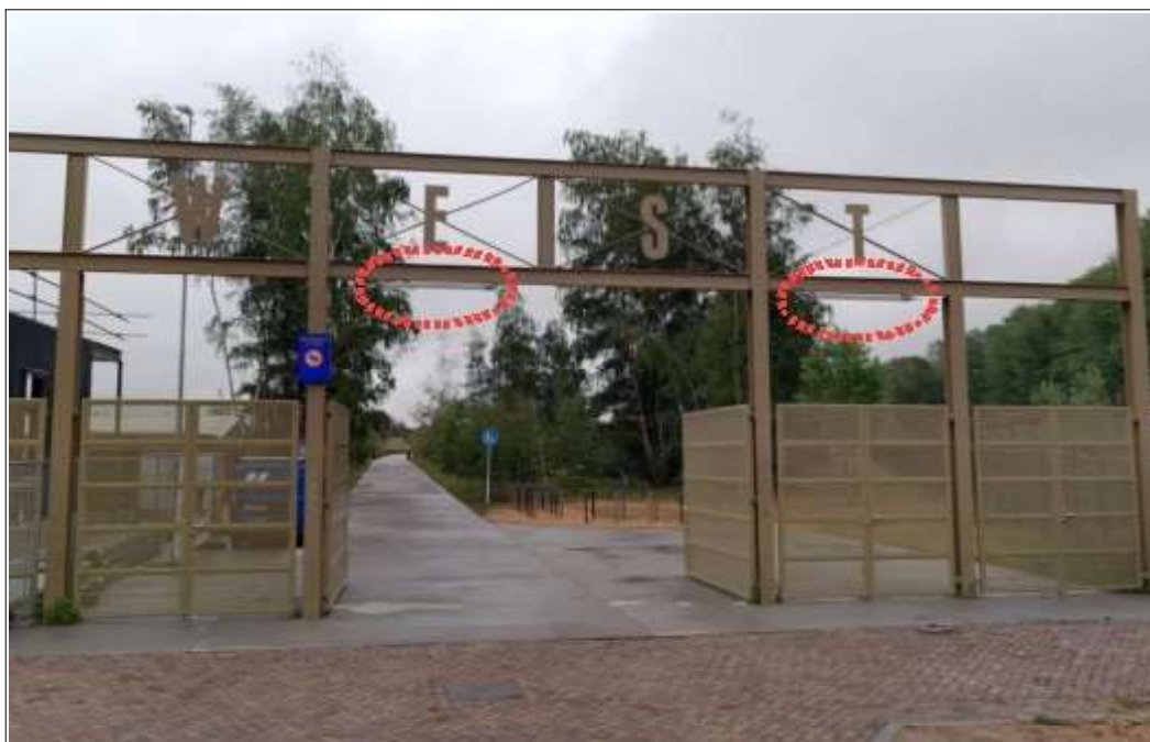
f2.4 Situering straatverlichtingsarmaturen toegangspoort Spoorpark (bron: Cyclomedia)
