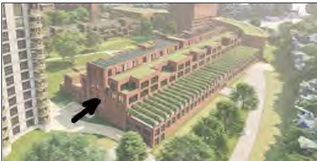
Figuur 22: Corridor in gebouw B Terrasblok West
