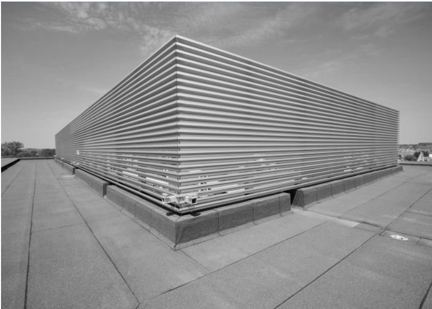
Referentiebeeld dakinstallaties op Leiespiegel Deinze, VK Architects & Engineers
