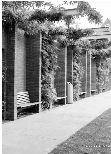
Erfafscheiding datacenter, Munthof Antwerpen
