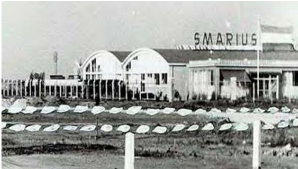
Voormalig gebouw Smarius. Betonelementen, schaaldaken en doosletters
