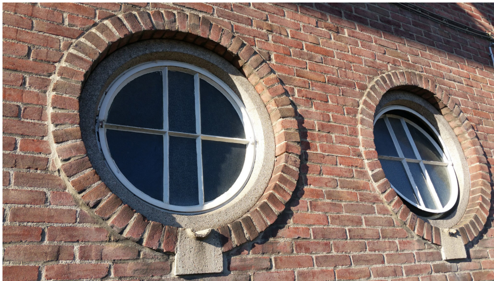
detail Lovense Kanaaldijk 47, 1952 Baksteenarchitectuur met verbijzonderingen in metselwerk
