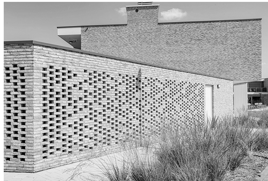
Erfafscheidingen in Braziliaans metselwerk
