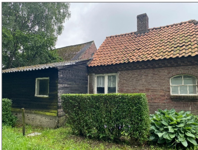
Afbeelding 4.1: Het dak bevat diverse openingen
