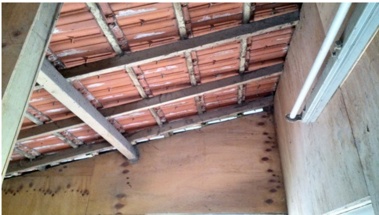
Afbeelding 5: Dakconstructie van de schuilschuur. Foto: V. Stuit | Ecoresult. B.V.
