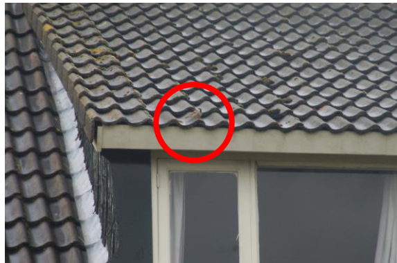
Huismus op dak
