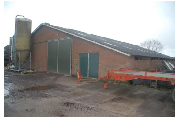
Achteraanzicht voormalige ligboxenstal.
