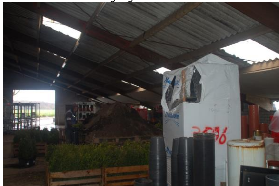
Binnenzijde voormalige ligboxenstal.
