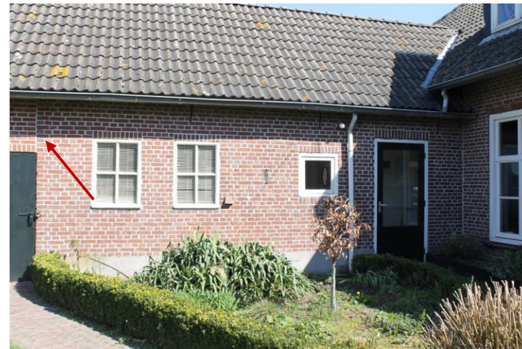
Rechterdeel linkerzijgevel bakhuis. De pijl geeft de bouwnaad aan.
