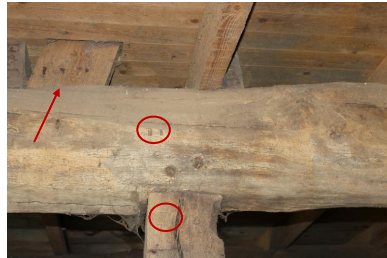
Telmerk II in rode cirkels op rechter rondhouten balk en gebintstijl. Bij de pijl is de kappoot (kreupele stijl) van het verbeterde Hollandse spant zichtbaar.
