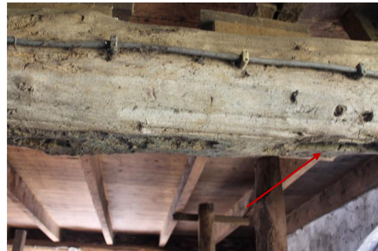
Aansluiting gebintstijl linker rondhouten balk (zie pijl).
