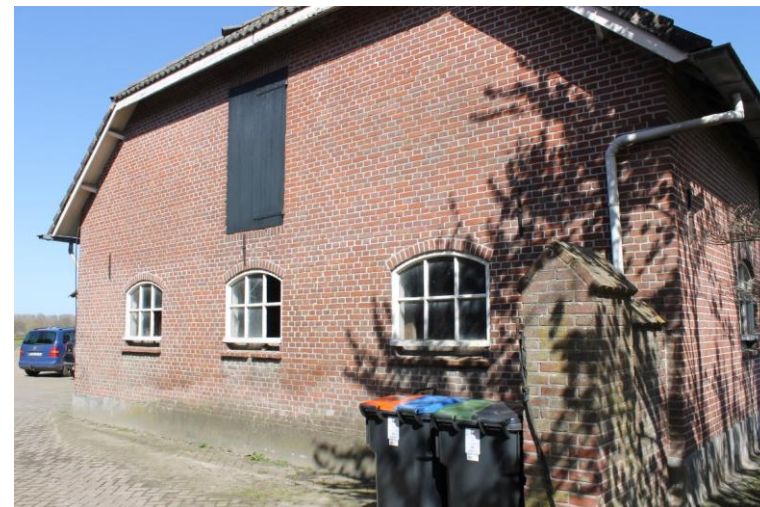
Linkerzijgevel van het bedrijfsdeel.
