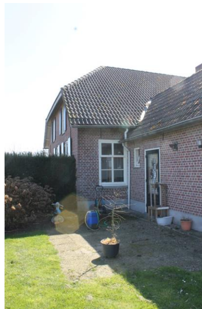
Achtergevel links van het aangebouwde bakhuis.
