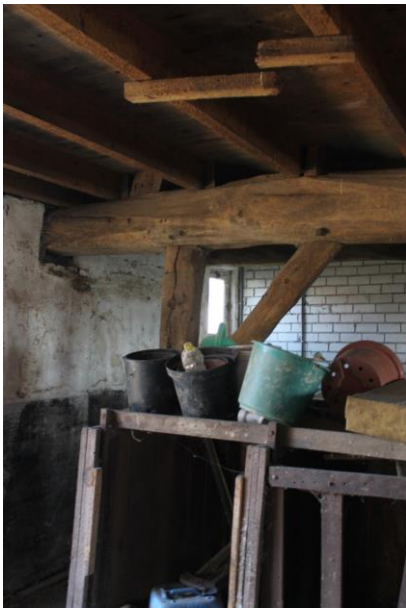
Aansluiting achtergevel met een ondersteunende gebintstijl.
