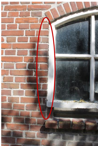
Aansluiting naast betonvenster.
