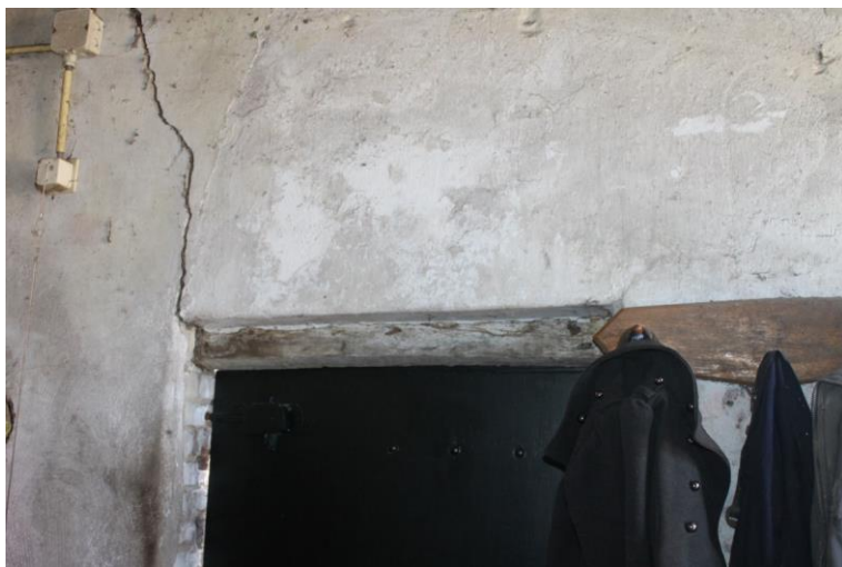
Binnenzijde opgeklampte loopdeur van het oorspronkelijke schuur onder houten latei.
