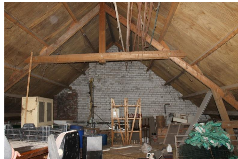
Vernieuwde verbeterd Hollandse spant.
