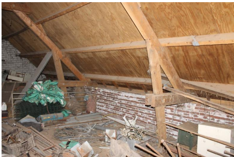
Aansluiting verbeterd Hollandsspant met de buitengevel.
