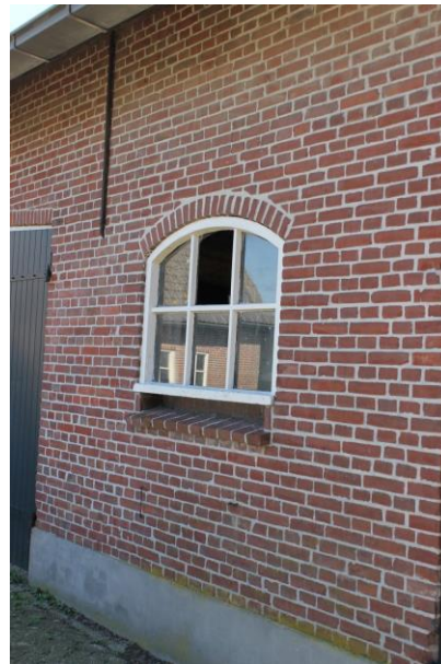
Betonvenster uit jaren '50.
