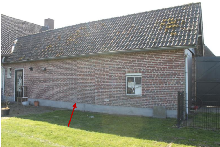
Rechterzijgevel bakhuizen. De pijl geeft de bouwnaad aan.
