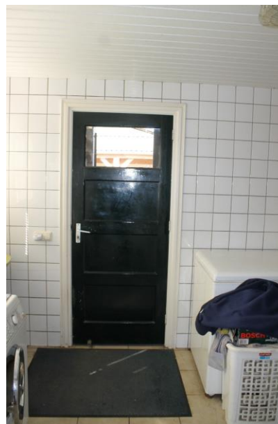
Scheidingsmuur tussen de aanbouw vanuit het latere bakhuis.
