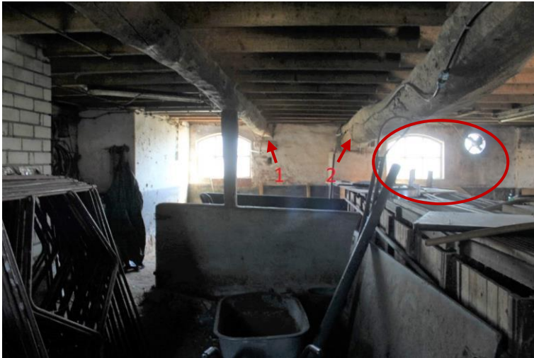
Rechts de zware rondhouten balk (2) en links de minder zware (1), beide balken bevinden zich links van de verwijderde dwarsdeeldeuren (cirkel).
