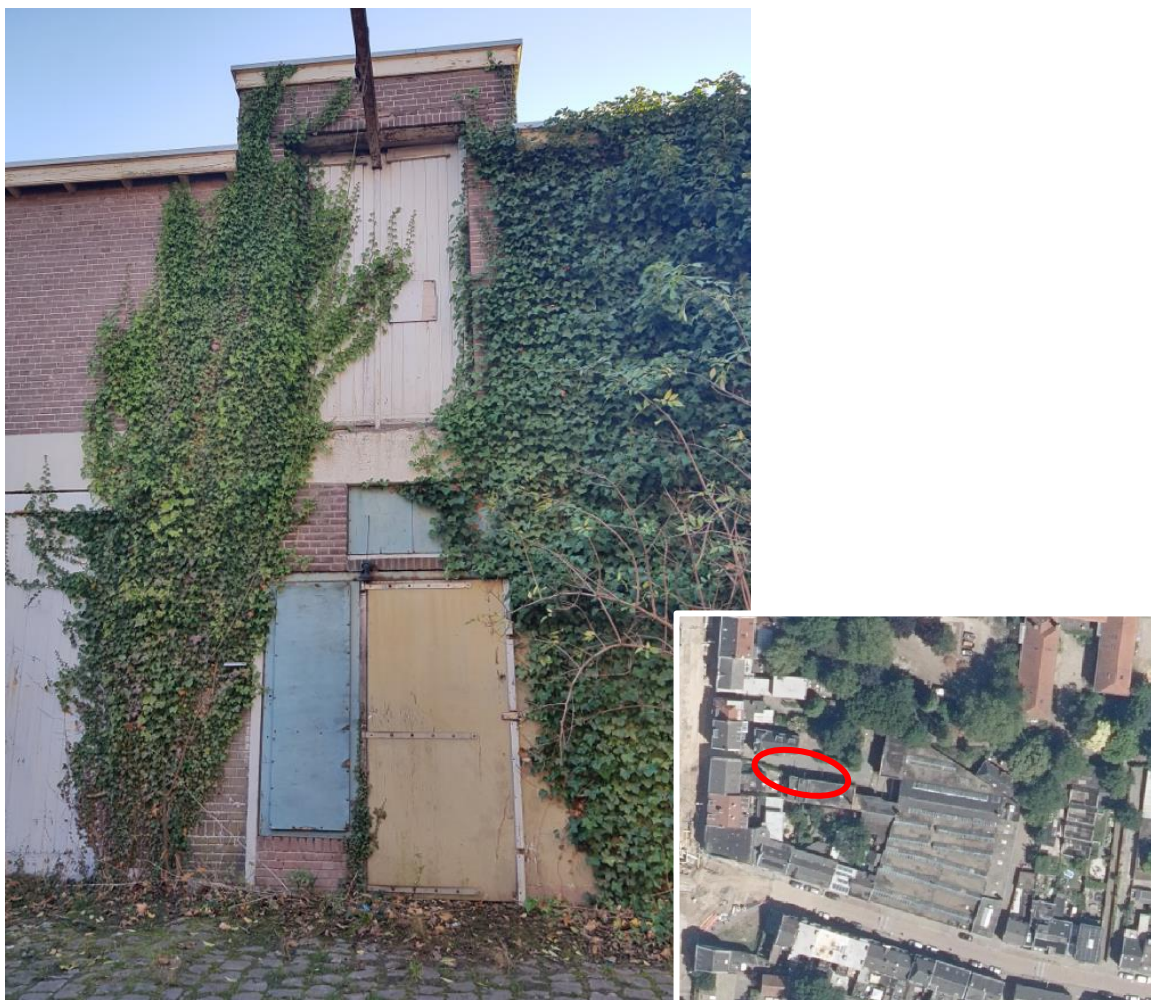
Figuur 6. De klimop die mogelijk deel uitmaakt van het functioneel leefgebied van de huismus. Aan de rechterzijde begint de haag die mogelijk ook een functie voor de huismus heeft. De rechterafbeelding geeft de locatie binnen het projectgebied weer.
