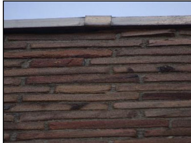
Figuur 16. Ruimte onder de daktrim in het voormalige schoolgebouw.
