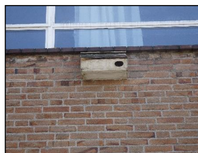
Figuur 14. Gierzwaluwkast aan de noordzijde van het voormalige schoolgebouw.
