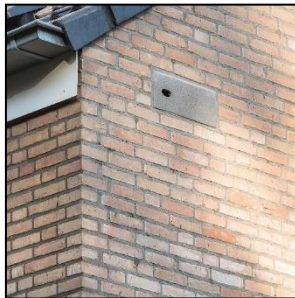
Figuur 24. Gierzwaluw: Ingebouwde kast type IB GZ 03 (bron: Vivara Pro).
