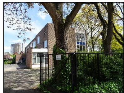
Figuur 5. Noordzijde voormalig schoolgebouw en aanplant.
