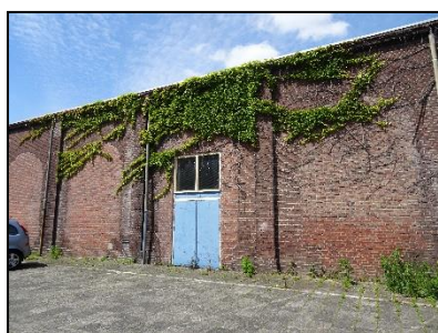
Figuur 12. Klimop aan de zuidzijde van het leegstaande pand.
