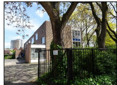
Figuur 5. Noordzijde voormalig schoolgebouw en aanplant.
