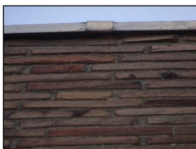
Figuur 15. Ruimte onder de daktrim in het voormalige schoolgebouw.
