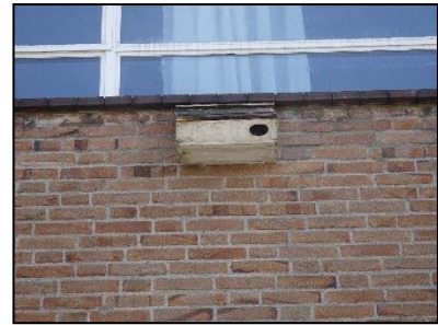
Figuur 12. Gierzwaluwkast aan de noordzijde van het voormalige schoolgebouw.
