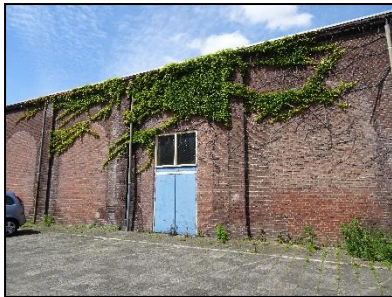
Figuur 10. Klimop aan de zuidzijde van het leegstaande pand.
