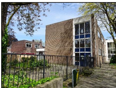
Figuur 6. West- en zuidzijde voormalig schoolgebouw en border met aanplant.
