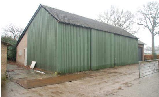
loods met garage
