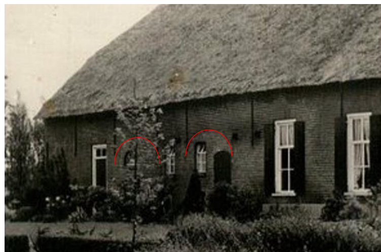
Detail bovenstaande foto met bouwsporen van de potstaldeuren in rood aangeduid.
