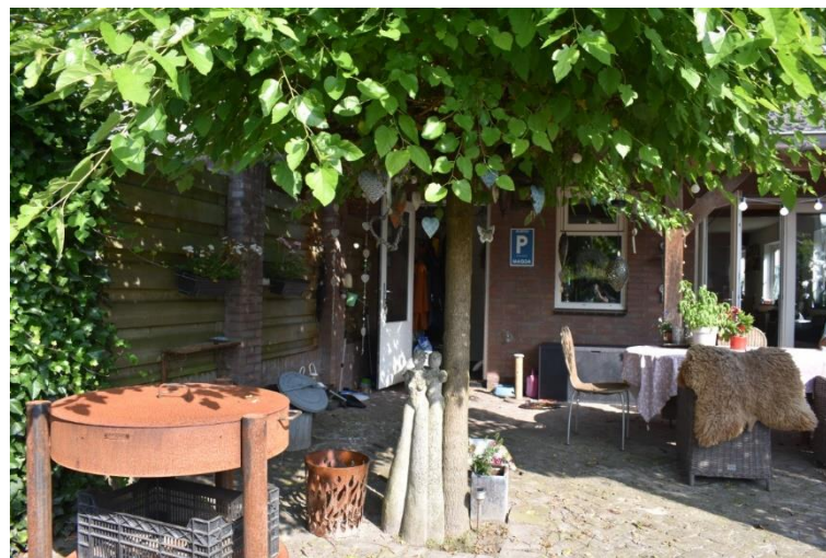
Opnieuw opgetrokken achtergevel van het bedrijfsgebouwt.
