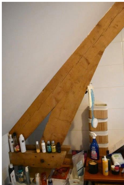
Spant boven bedrijfsgedeelte.
