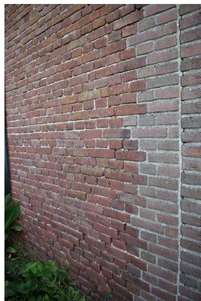
Bouwnaad in de rechterzijgevel.
