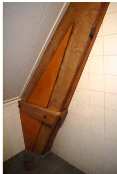
Spant boven bedrijfsgedeelte.
