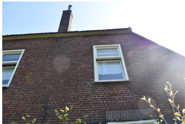
Vernieuwde vensters op verdieping en 'dubbele' strek boven het rechter venster op de begane grond.
