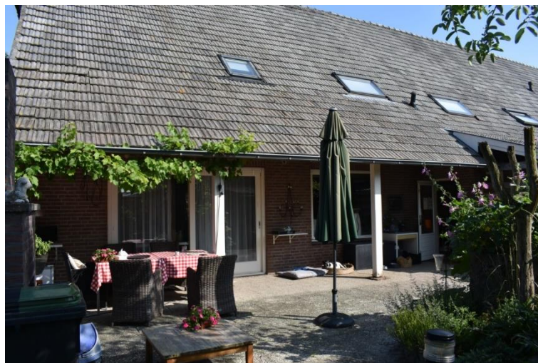
Opnieuw opgetrokken achtergevel van het woongedeelte.
