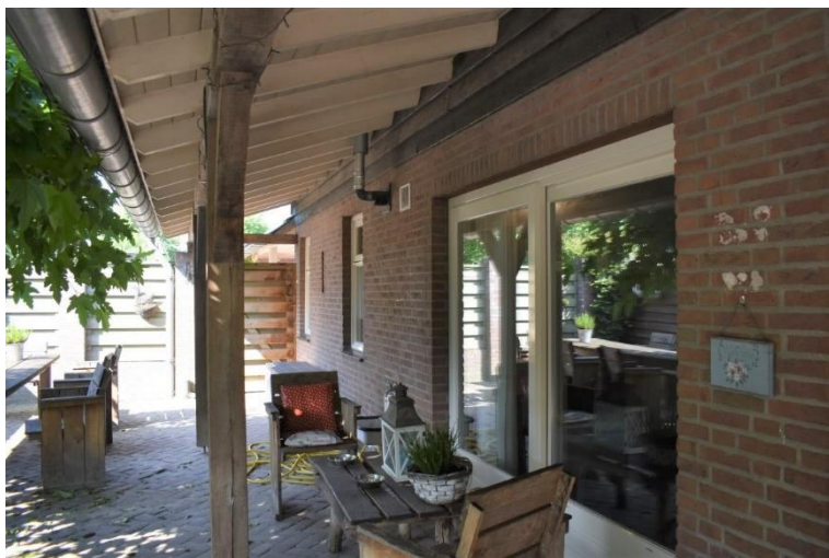
Opnieuw opgetrokken achtergevel van het bedrijfsgebouwt.
