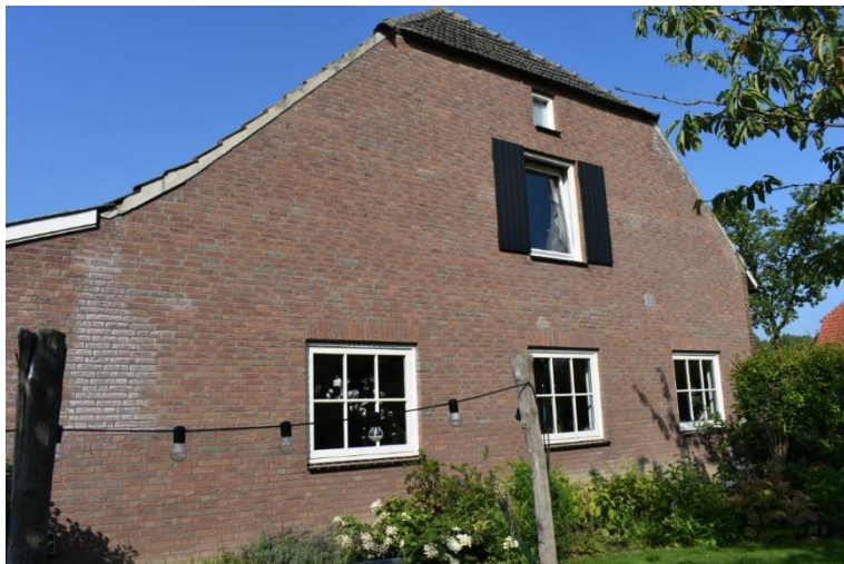
Opnieuw opgetrokken linkerzijgevel.
