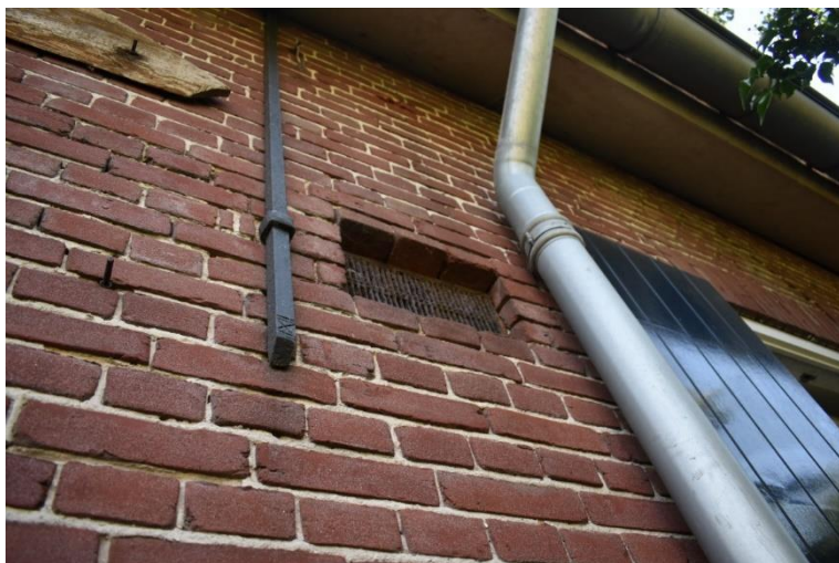
Oorspronkelijk ventilatierooster.
