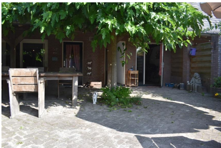
Opnieuw opgetrokken achtergevel van het bedrijfsgebouwt.
