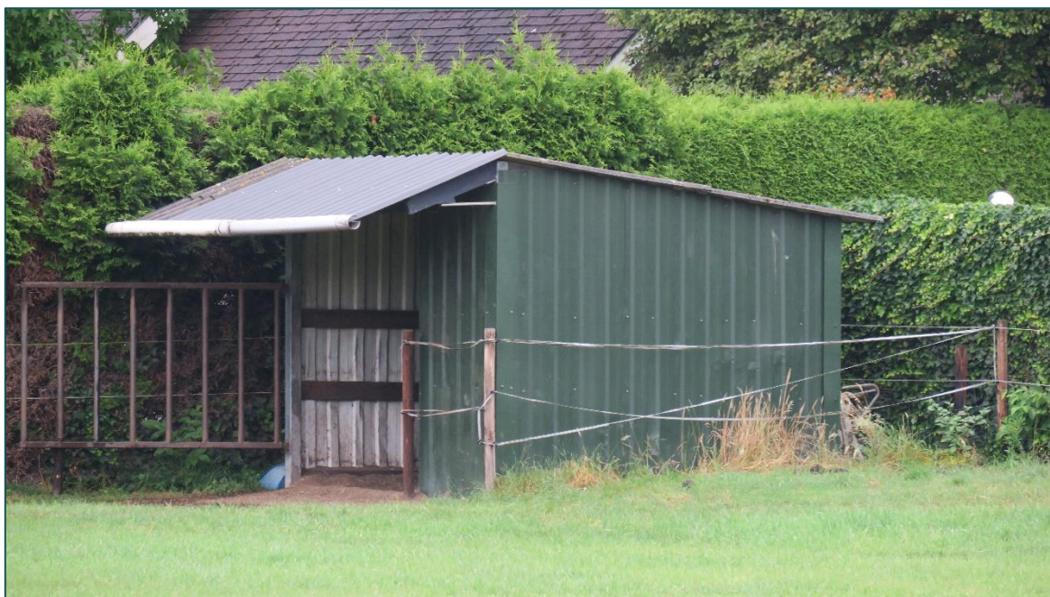
Figuur 3 De kleine opstal op de planlocatie is opgebouwd uit metalen damwandplaten.
