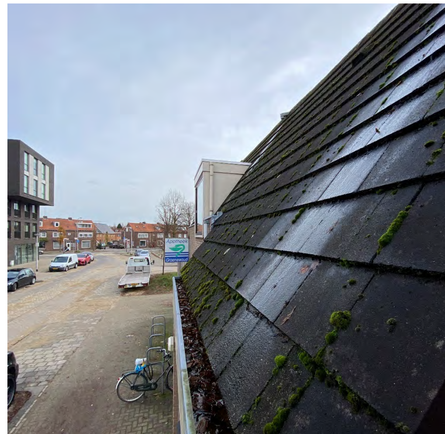
Figuur 12. Beeld van de dakbedekking.
