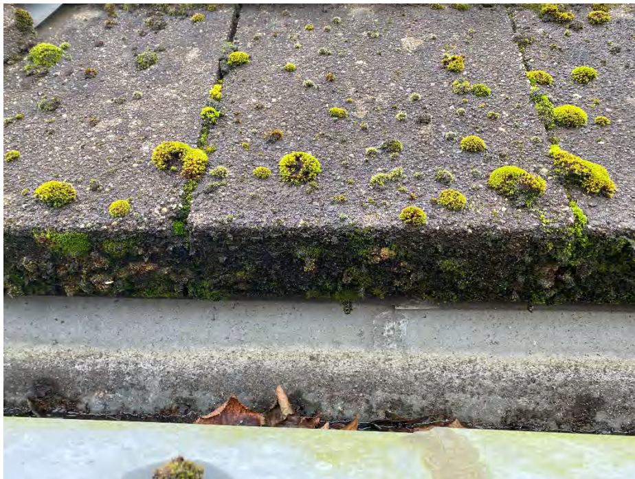
Figuur 13. Beeld van de overgang naar de dakgoot.
