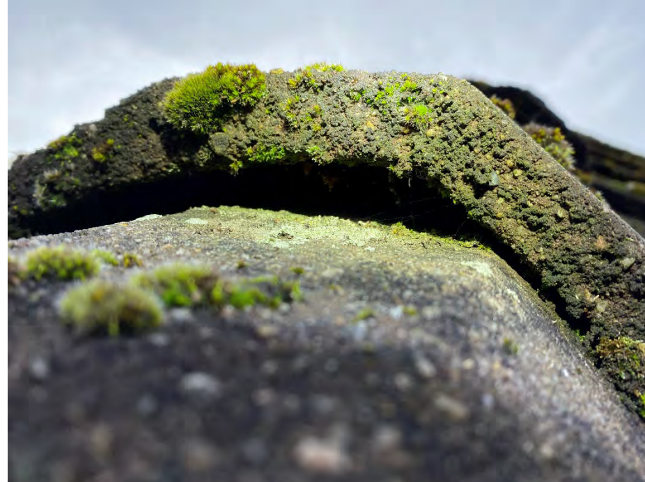
Figuur 14. Er is bij de nokvorsten van de hoekkepers voldoende ruimte aanwezig voor vleermuizen om de ruimte onder de nokvorsten te bereiken.
