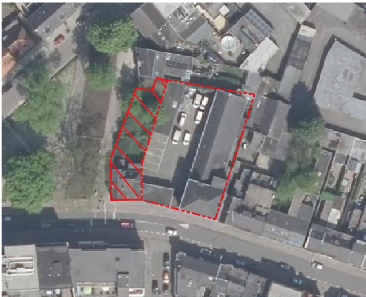
Figuur 2.1: Luchtfoto onderzoekslocaties (in rood). Gearceerd: Veldhovenring 39, overig: Veldhovenring 37a+b.
